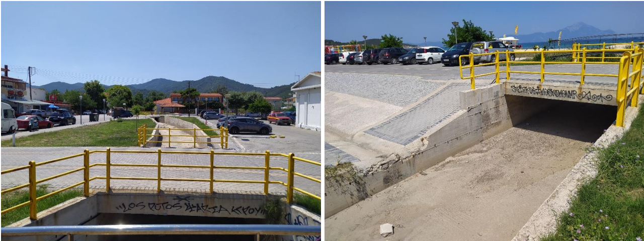
Εικόνα 3-24 Πρόσφατο έργο διευθέτησης της κοίτης του Κεντρικού ρέματος Σάρτης
