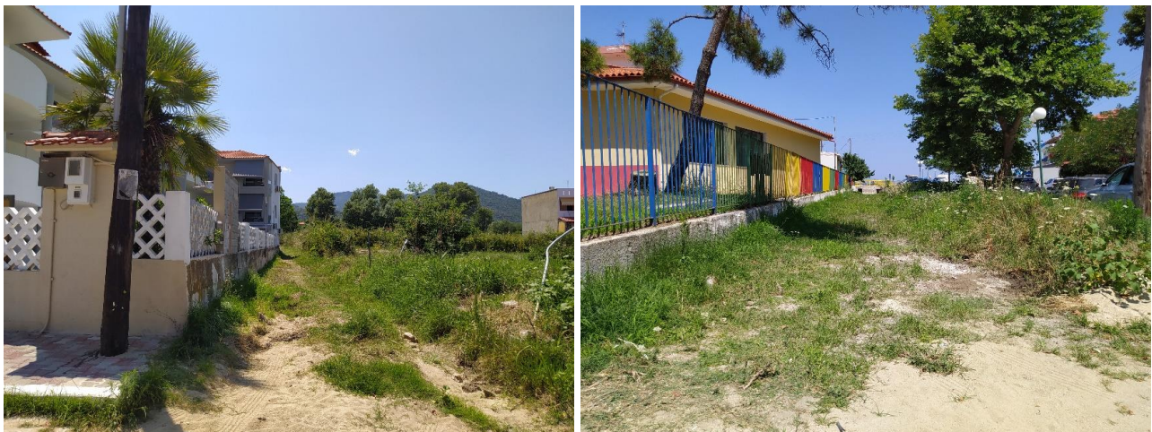
Σε επαφή με οικίες 100μ πριν την εκβολή – όψη προς ανάντη - Σε επαφή με το Δημοτικό σχολείο Σάρτης – όψη προς τα κατάντη (αυτοψία Ιούλιος 2023)
