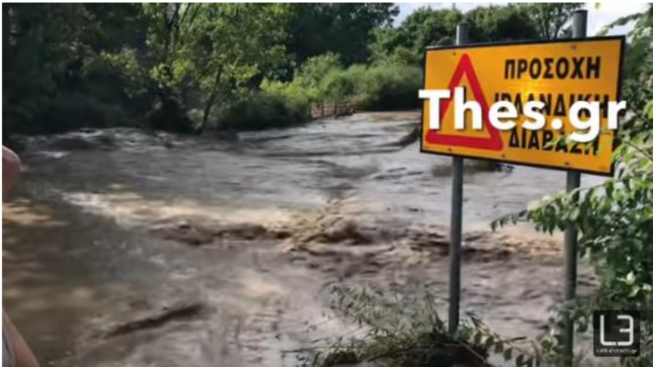
Εικόνα 3-8: Επιπτώσεις της πλημμύρας 12/06/2021 – υπερχίλιση στη θέση ιρλανδικής διέλευσης όπου παρασύρθηκε όχημα (πηγή: tvxs, thes.gr)
