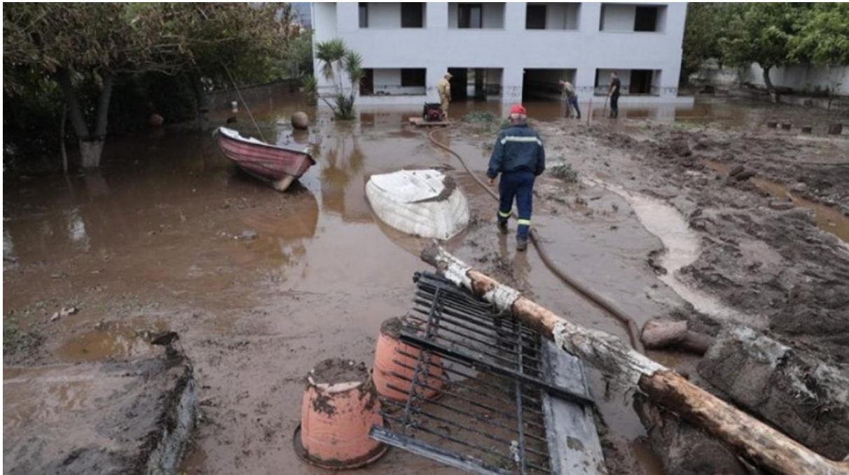
Σχήμα 3.32: Πλημμυρισμένες εκτάσεις στην Βόρεια Εύβοια
