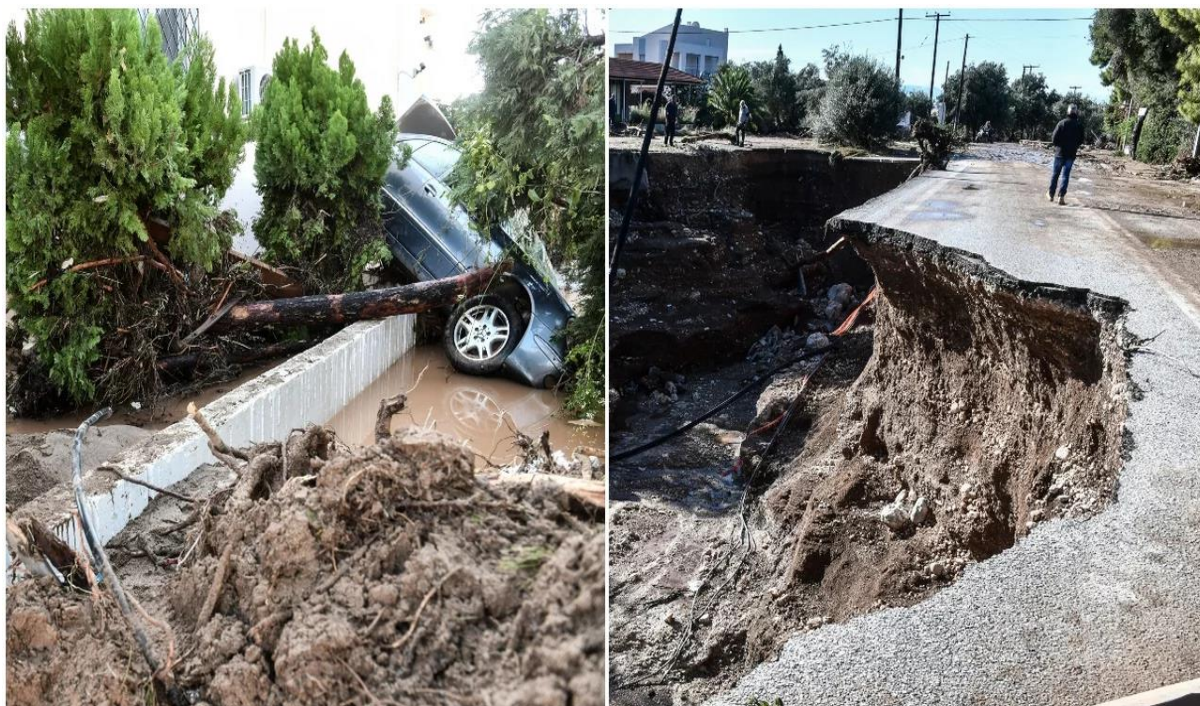
Σχήμα 3.7: Καταστροφές στο οδικό δίκτυο στην Κινέτα (Πηγή: iefimerida.gr)
