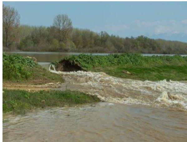
Σχήμα 1-8: Σπασμένο ανάχωμα στην περιοχή του Πεθελινού 29/03/2015.
