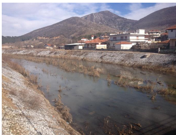
Σχήμα 4-10: Κ. Νευροκόπι, κατάντη του Φράγματος της Λευκόγειας
