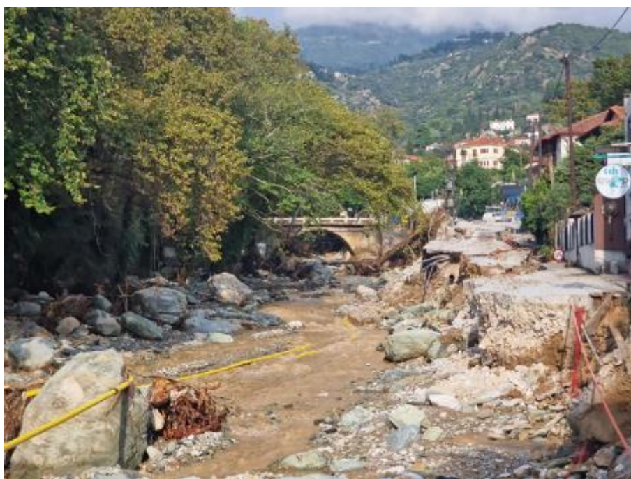
Εικόνα 3-27 Κατάρρευση του παραποτάμιου δρόμου στον ποταμό Κραυσίδωνα στο ύψος του Άνω Βόλου (πηγή: https://www.protothema.gr/ )
