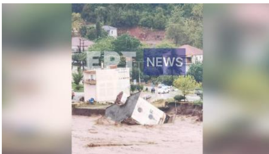
Εικόνα 4-23 Κτίριο στο Μουζάκι Καρδίτσας που «έπεσε» (πηγή: https://www.ertnews.gr/ )
