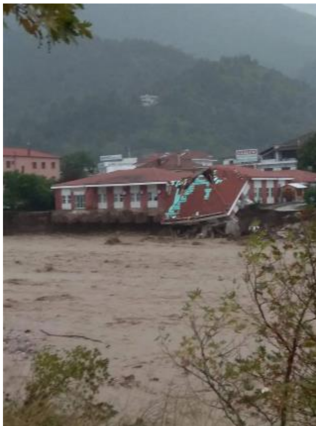
Εικόνα 4-4 Κατάρρευση κτιρίου λόγω της πλημμύρας στον νομό Καρδίτσας. (πηγή: https://www.protothema.gr/ )
