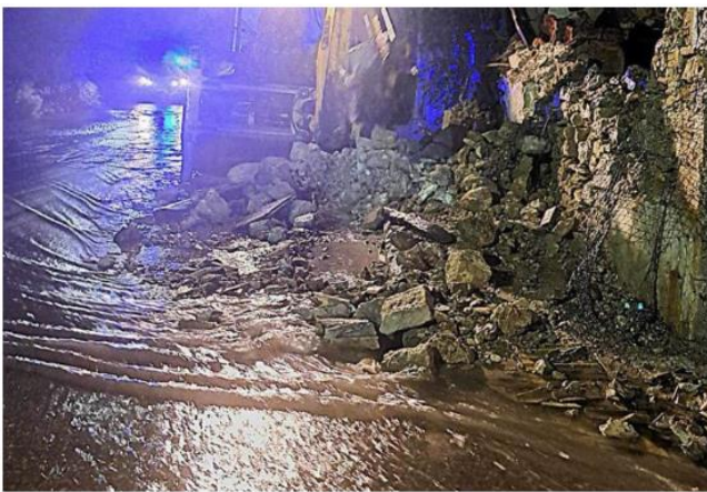
Φωτογραφία 3.1: Κατάρρευση τοιχίου στο Καλλιτέρο, 10/2024 (Πηγή: https://www.kefaloniapress.gr/topika/kairos/article/707987/provlimata-sti-zakyntho-apo-tin-kakokairia-atena/ )
