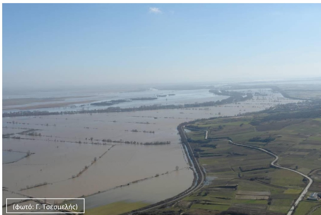
Εικόνα 2-20: Το αγρόκτημα Λαγυνών και η σιδ/κή γραμμή κατά τις πλημμύρες του 2010
