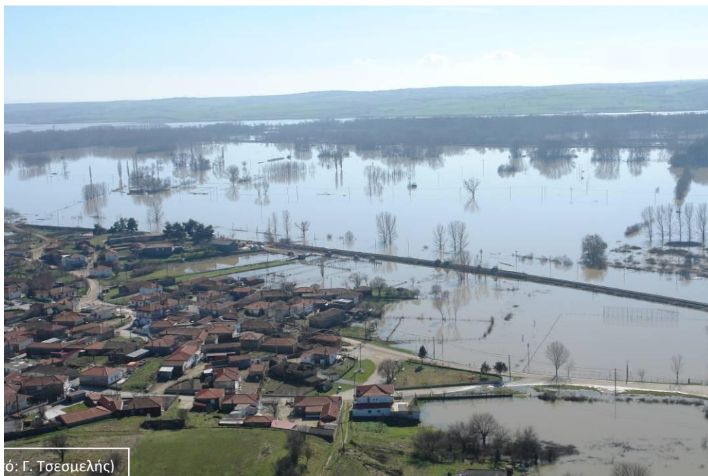
Εικόνα 2-19: Ο οικισμός Πραγγίου και η σιδ/κή γραμμή κατά τις πλημμύρες του 2010
