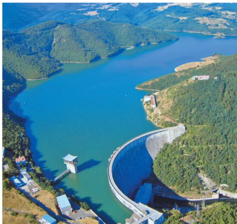
Εικόνα: Φράγμα Kardjali Dam (πηγή Google Earth)
