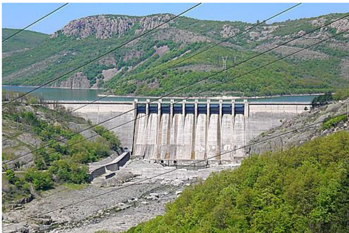
Εικόνα: Φράγμα Studen Kladenets (πηγή Google Earth)
