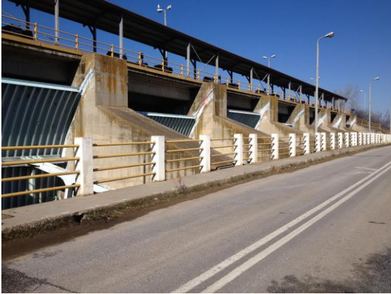
Σχήμα 3-9: Θυροφράγματα στο Φράγμα Λιθότοπου-Κερκίνης.
