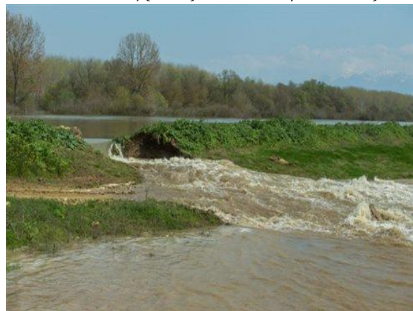
Σχήμα 3-12: Σπασμένο ανάχωμα στην περιοχή του Πεθελινού 29/03/2015.
