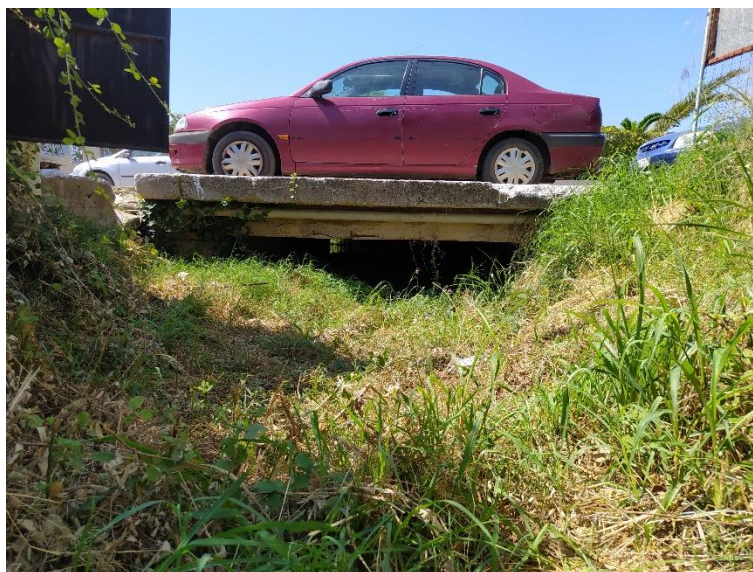
Εικόνα 3-27. Ρέμα 3 Γερακινής, τεχνικό επί της Επαρχιακής Οδού Λιμένος – Γερακινής
