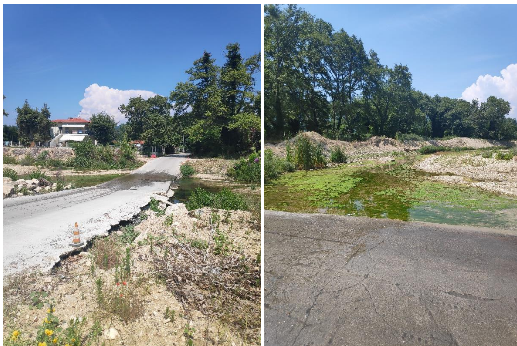
Εικόνα 3-4. Ρέμα Μαυρόλακκας στην περιοχή της οδού Μεγ. Αλεξάνδρου
