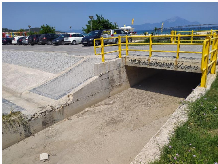
Εικόνα 3-54 Διευθέτηση της κοίτης του Κεντρικού ρέματος Σάρτης
