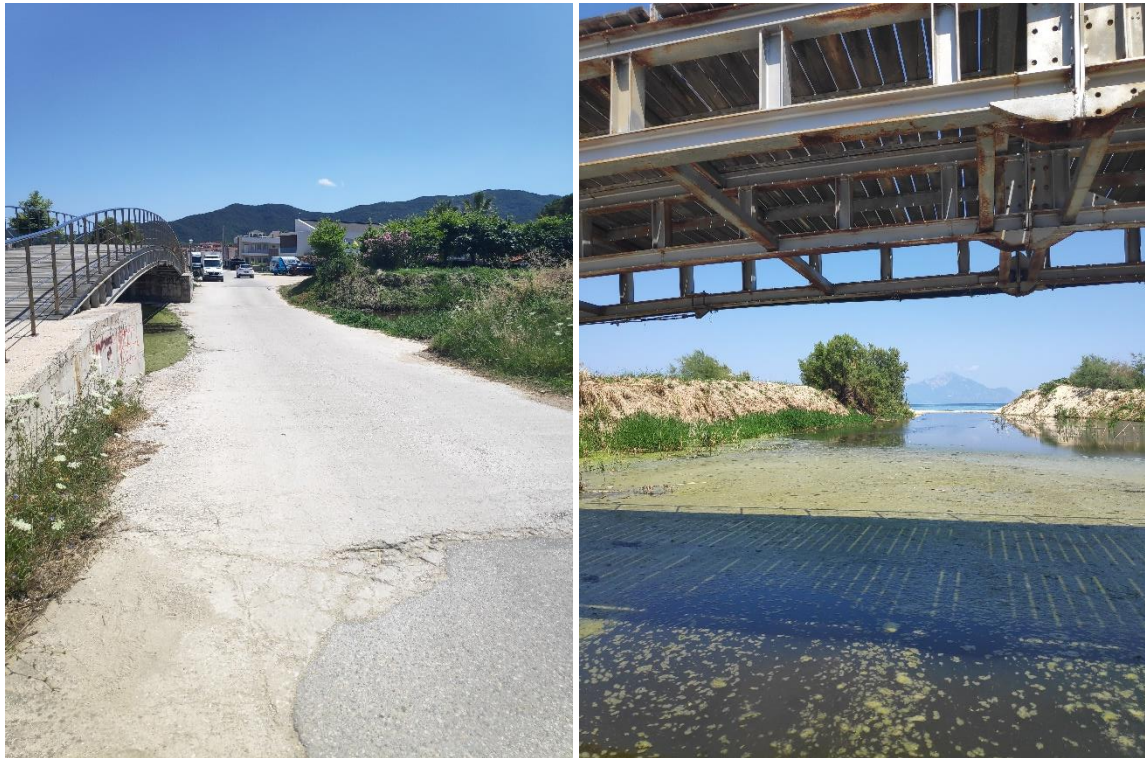
Εικόνα 3-55 Ιρλανδική διάβαση πριν την εκβολή του Νότιου ρέματος Σάρτης, περιοχή εκβολής (αυτοψία Ιούλιος 2023)
