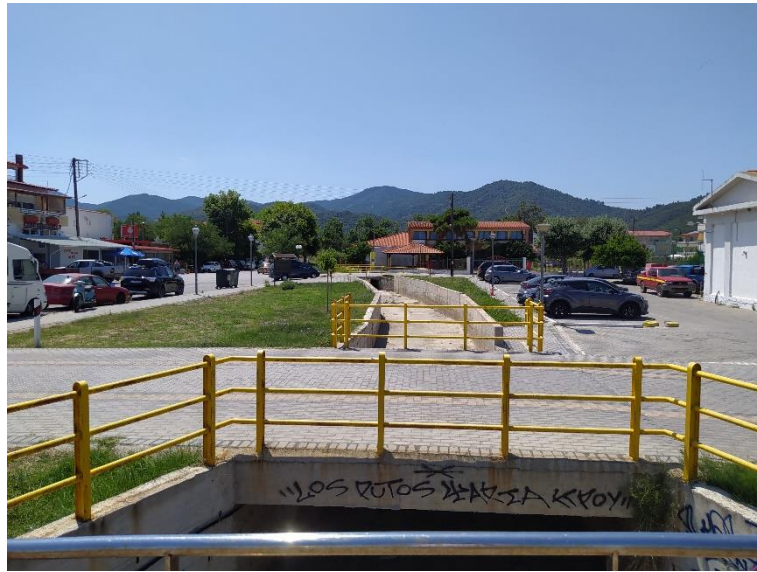
Εικόνα 3-53 Πρόσφατο έργο διευθέτησης της κοίτης του Κεντρικού ρέματος Σάρτης
