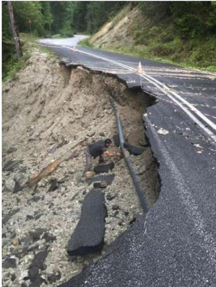
**Εικόνα 3-12. Ασφαλτοστρωμένος δρόμος Βελβεντού - Καταφυγίου- Καθίζηση οδοστρώματος.**
