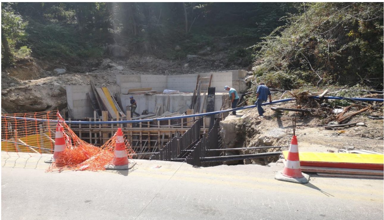
Φ 3-14 Το ίδιο τεχνικό, όψη από κατάντη προς ανάντη.
