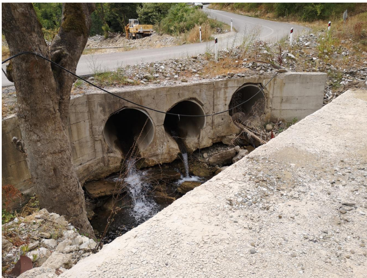
Φ 3-18 Κατάντη όψη του τεχνικού διάβασης. Δεξιά διακρίνεται τμήμα της παλαιάς γέφυρας.
