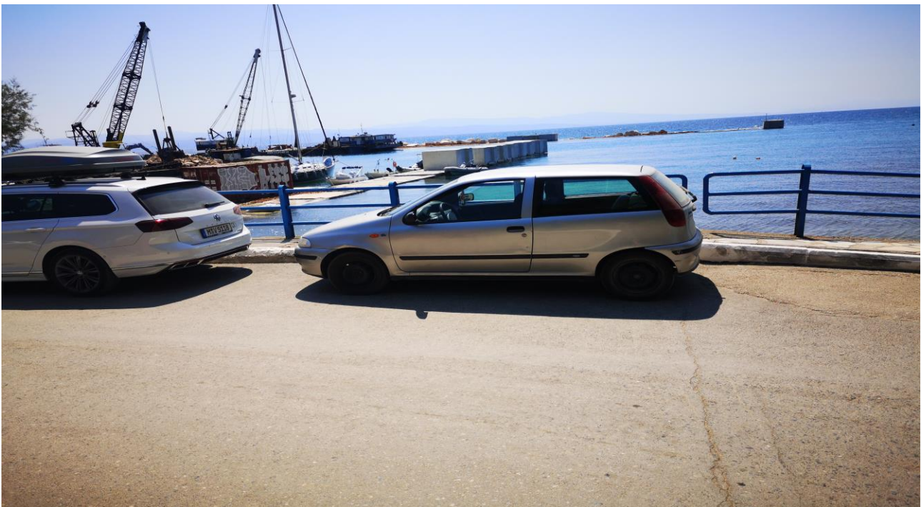
Φ 3-9 Το αλιευτικό καταφύγιο υπό κατασκευή κοντά στην εκβολή του Χαλορέματος. Άποψη από το κατάστρωμα της γέφυρας.
