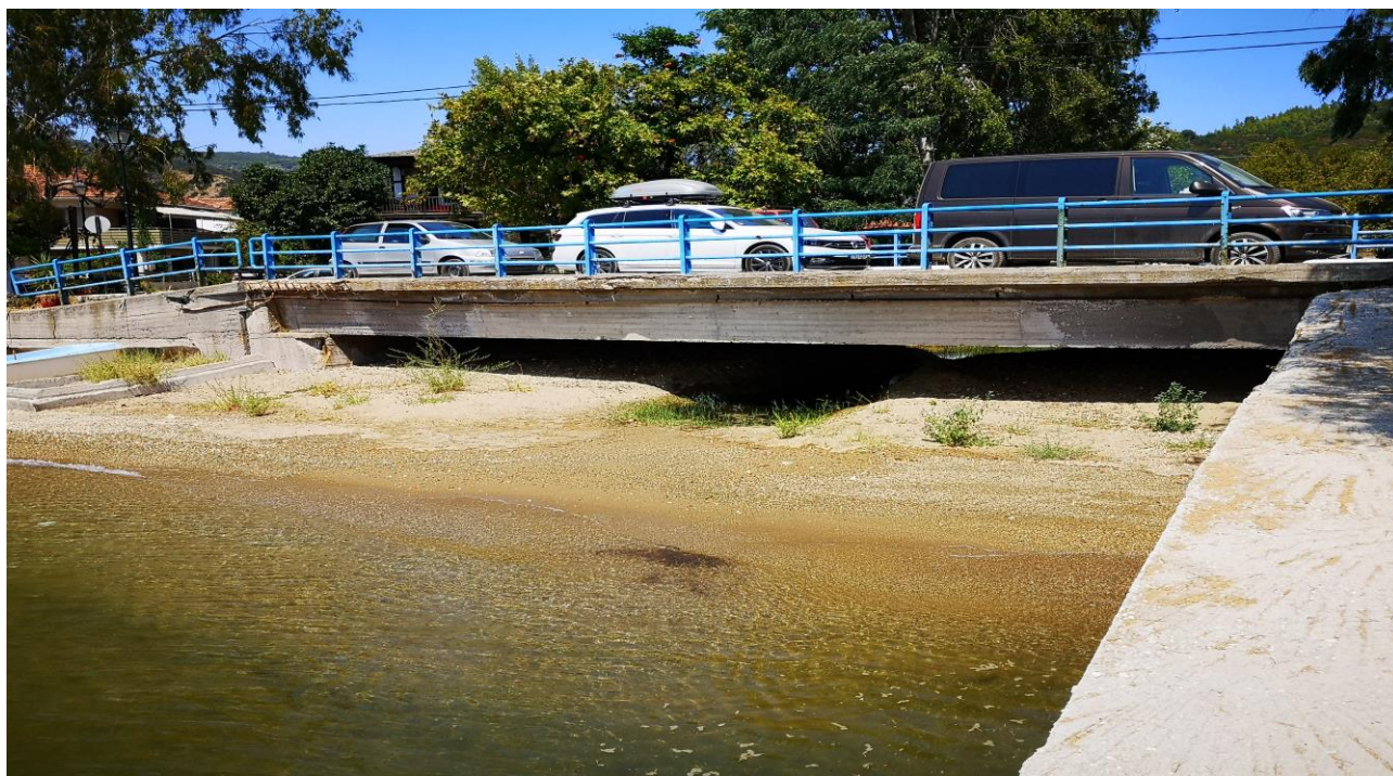
Φ 3-7 Ανάντη άποψη της γέφυρας. Διακρίνεται συσσώρευση φερτών υλών.
