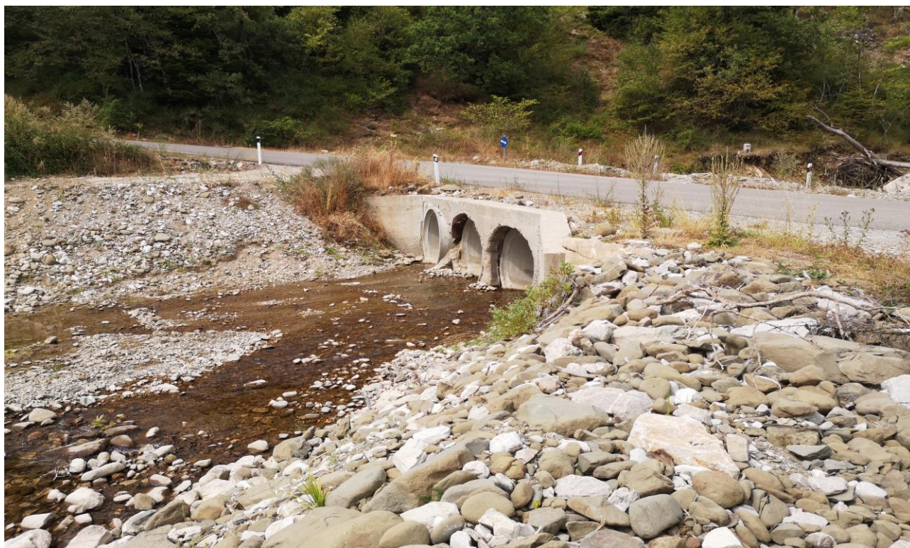
Φ 3-20 Ανάντη άποψη του τεχνικού.
