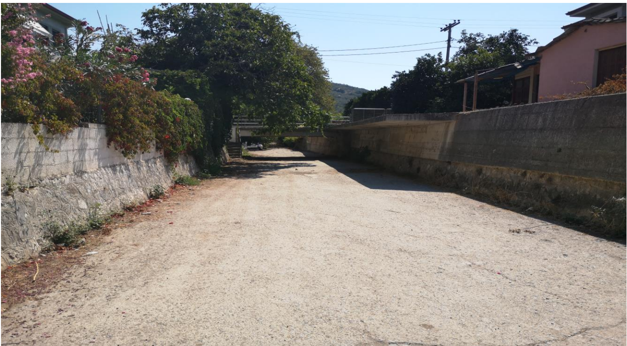
Φ 3-2 Η γέφυρα από κατάντη. Σημειώνεται ότι οι εκατέρωθεν κατοικίες προστατεύονται από τοίχους. Το ύψος των τοίχων δείχνει το βάθος νερού στις «συνήθεις» πλημμύρες.
