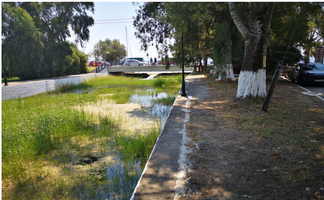
Φ 3-5 Πλατανιάς. Άποψη της διευθετημένης κοίτης του Χαλορέματος κοντά στην εκβολή. Στο βάθος η γέφυρα.
