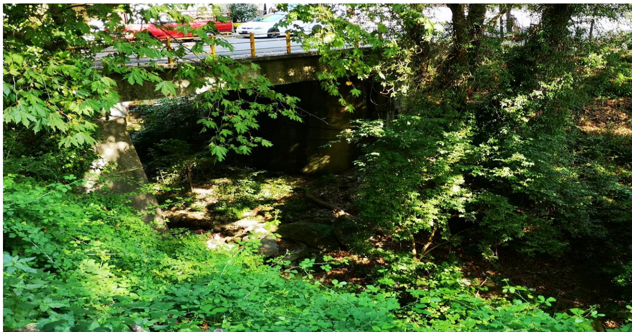
Φ 3-10 Ζαγορά, κεντρικός δρόμος, αρχή οικισμού. Κατάντη όψη γέφυρας.
