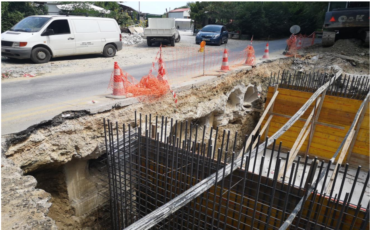
Φ 3-13 Ζαγορά, οδός προς Πουρί, στο ύψος «Οικοδομικά Υλικά Βασιλείου». Κατασκευή νέου τεχνικού διάβασης χειμάρρου. Διακρίνονται οι υφιστάμενοι ανεπαρκείς σωληνωτοί οχετοί. Από ανάντη προς κατάντη.
