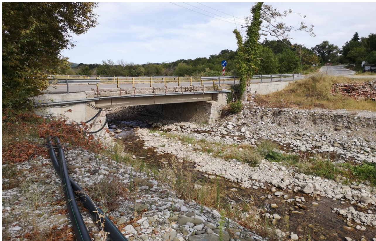
Φ 3-23 Ανάντη όψη του τεχνικού. Διακρίνονται τα φερτά υλικά στις όχθες.
