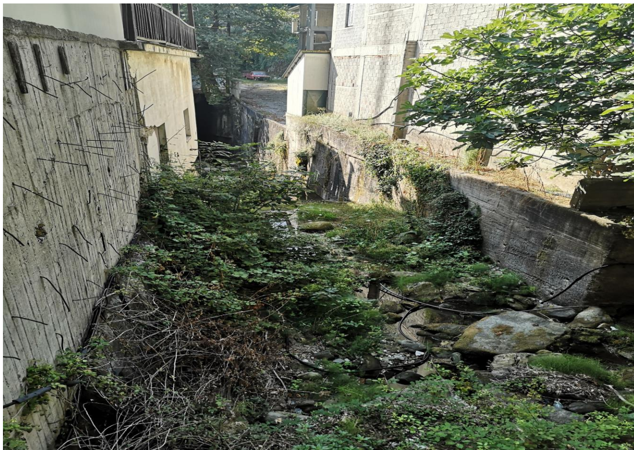
Φ 3-11 Όψη της διαδρομής του χειμάρρου, ανάντη της γέφυρας.
