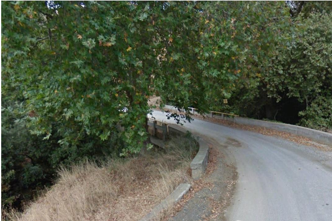
Σχήμα 3.11: Τεχνικό διέλευσης στην επαρχιακή οδό Ραχών
