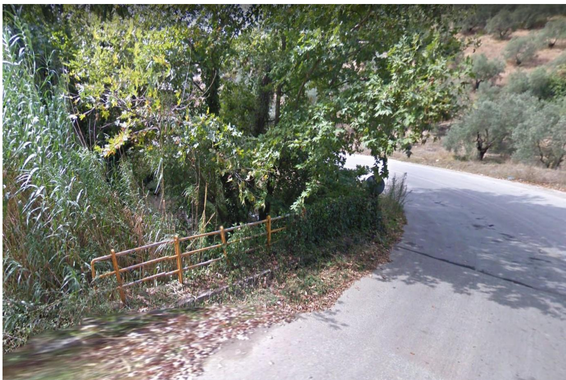
Σχήμα 3.9: Οχετός προς τα κατόντη της κοίτης του ρέματος
