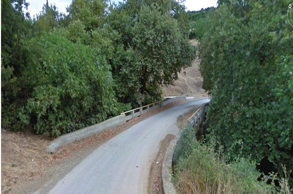
Σχήμα 3.10: Τεχνικό διέλευσης στην επαρχιακή οδό Ραχών
