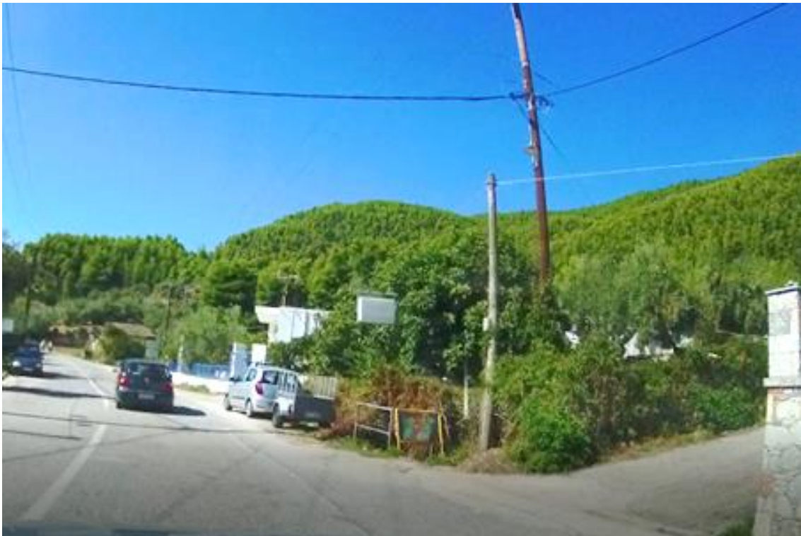
Σχήμα 3.17: Φραγμένος Οχετός στον οικισμό Νέου Κλήματος
