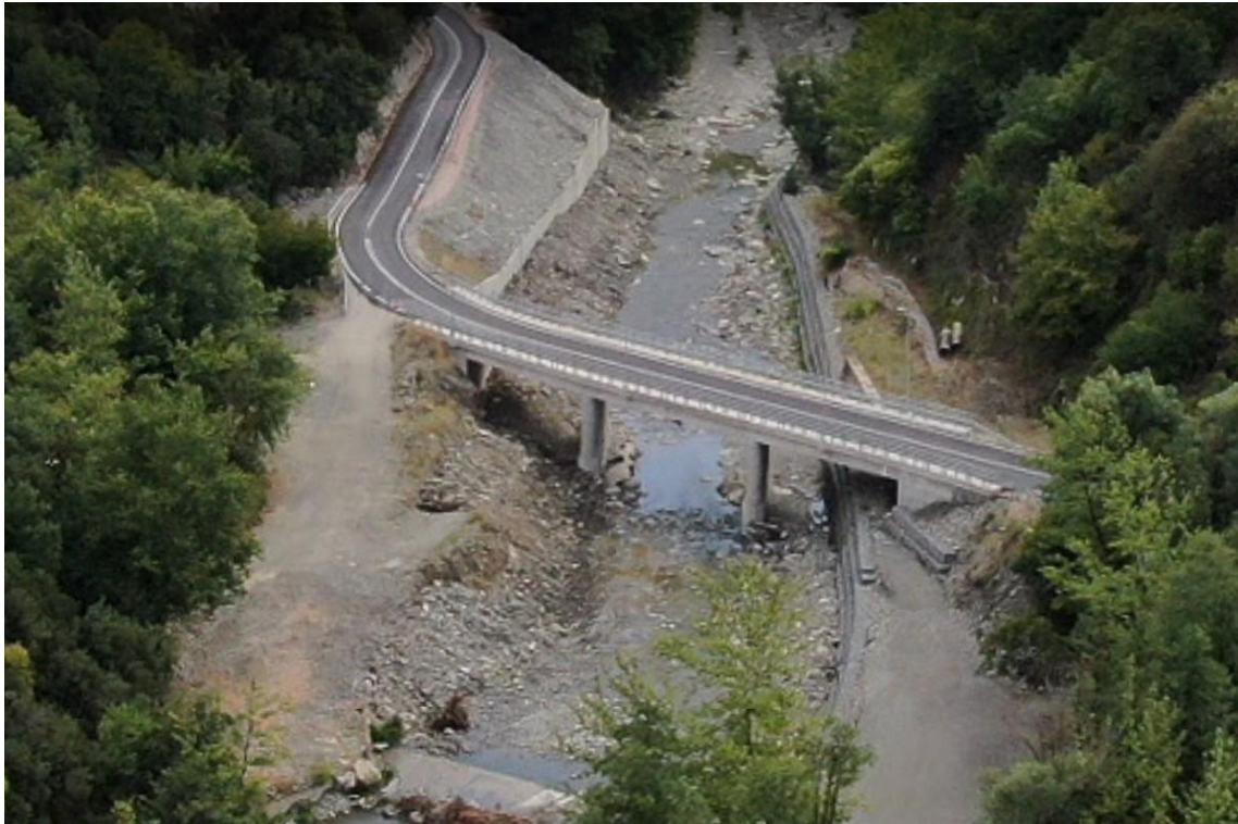
Σχήμα 3.13: Νέα γέφυρα Περιβολίου από ψηλά
