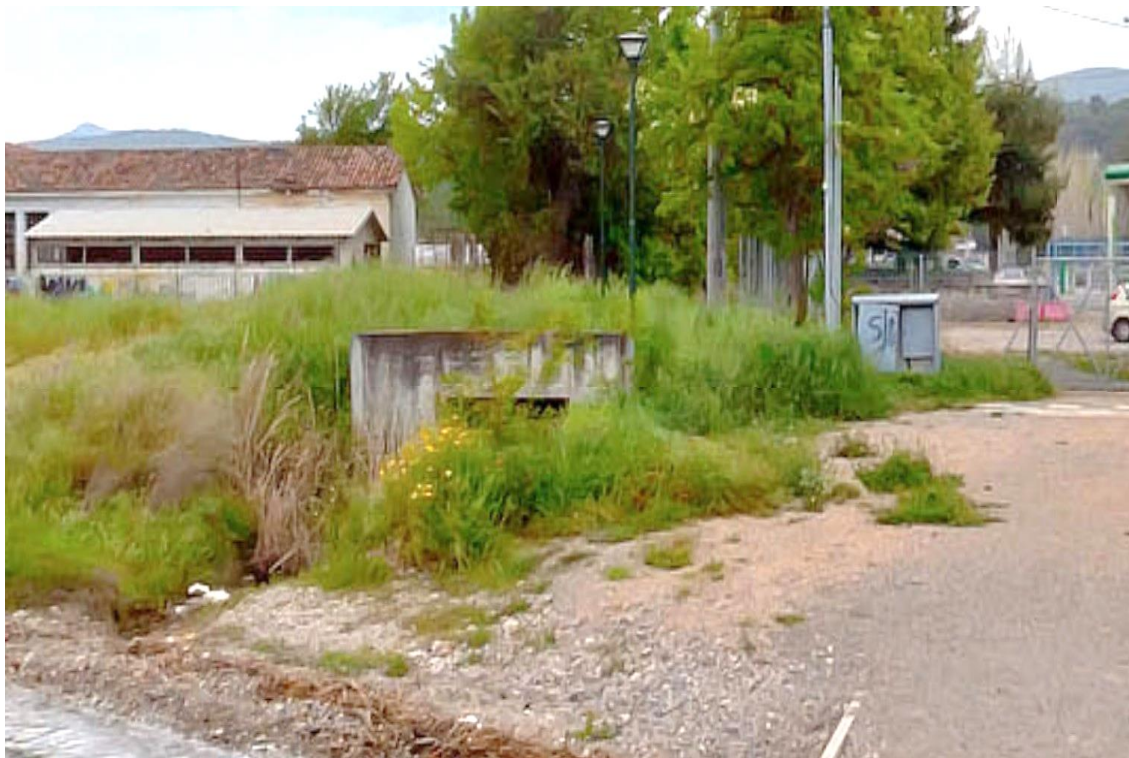
Σχήμα 3.3: Εκβολή ρέματος Βίριζα στην θάλασσα μέσω οχετού.
