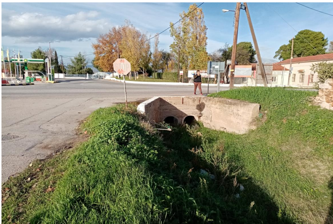
Σχήμα 3.2: Διασταύρωση ρέματος Βίριζα μέσω σωληνωτού οχετού με την οδό Αμφιαρείου-Χαλκουτσίου
