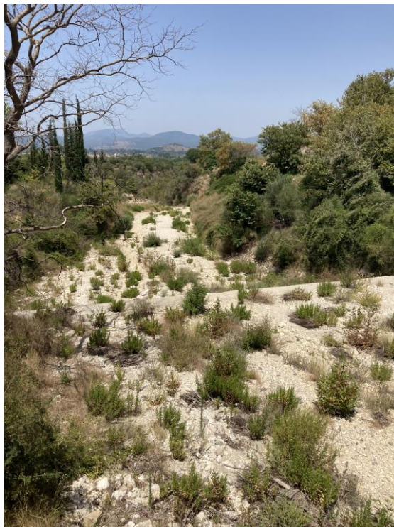
Φ 3-18 Ρέμα που διέρχεται από τον οικισμό Σκεπαστό στο Δήμο Φαναρίου. Ανάντη άποψη τεχνικού. Διακρίνεται η ανάπτυξη πυκνής βλάστησης.
