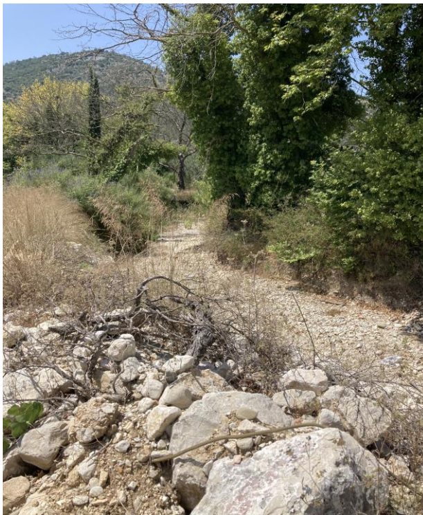
Φ 3-16 Ρέμα Ξένη στον Δήμο Φαναρίου, οικισμός Καναλλάκι. Ανάντη άποψη. Μεγάλη ποσότητα φερτών τα οποία πιθανόν να έχουν αποτεθεί από παλαιότερο καθαρισμό.
