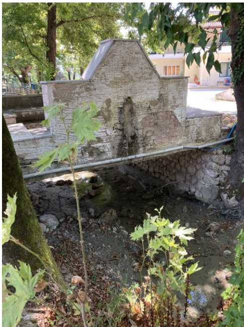
Φ 3-2 Τεχνικό στο ρέμα που διέρχεται από τον Οικισμό της Χρυσσαυγής. Ανάντη άποψη.
