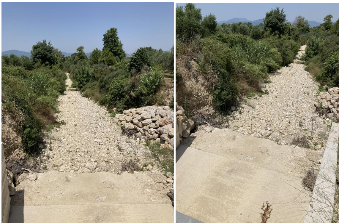
Φ 3-20 Οικισμός Νάρκισσος Δήμου Φαναρίου. Ρέμα που διέρχεται κάθετα στην ΕΟ Καναλλακίου – Νεράιδας. Σημαντικός περιορισμός της διατομής λόγω πολύ πυκνής βλάστησης. Διακρίνεται κατοικία πλησίον του ρέματος.
