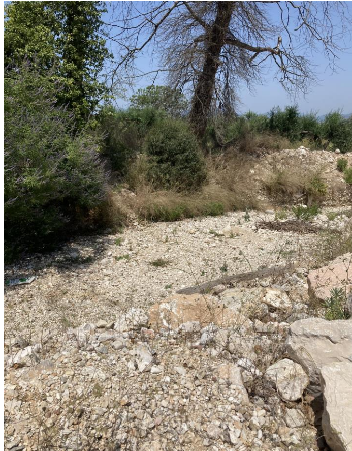
Φ 3-15 Ρέμα Ξένη στην περιοχή Φανάρι, οικισμός Καναλλάκι. Ανάντη άποψη. Διακρίνεται μεγάλη ποσότητα φερτών τα οποία πιθανόν να έχουν αποτεθεί από παλαιότερο καθαρισμό.
