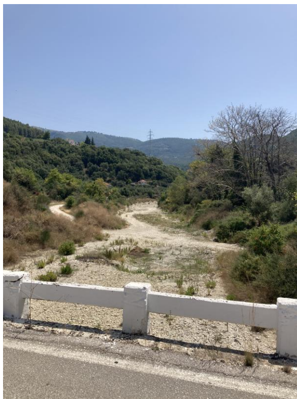
Φ 3-17 Ρέμα που διέρχεται από τον οικισμό Σκεπαστό στο Δήμο Φαναρίου. Ανάντη άποψη τεχνικού. Διακρίνεται η ανάπτυξη βλάστησης εντός της κοίτης.
