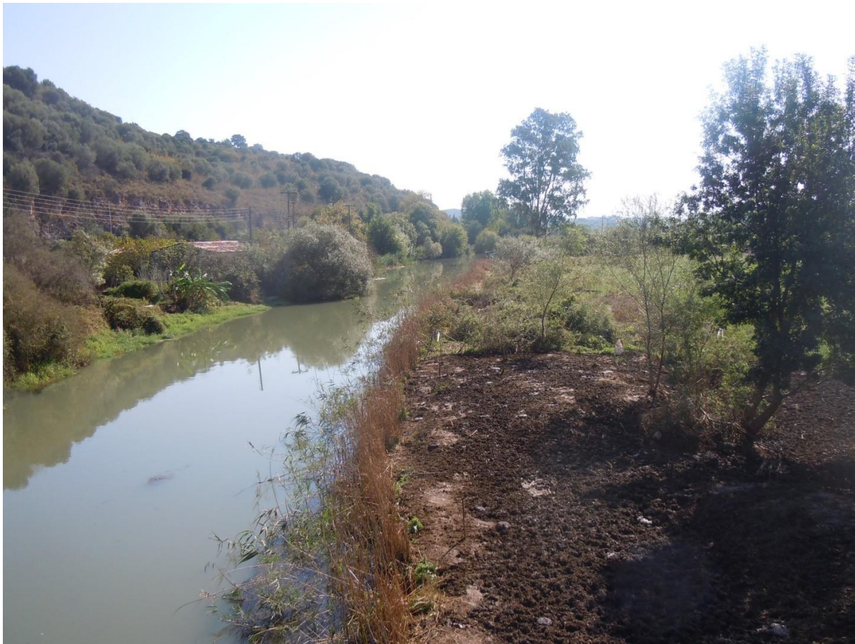
Φωτ. 8: Π. ΛΟΥΡΟΣ, ΑΝΑΝΤΗ ΓΕΦΥΡΑΣ ΠΕΤΡΑΣ
