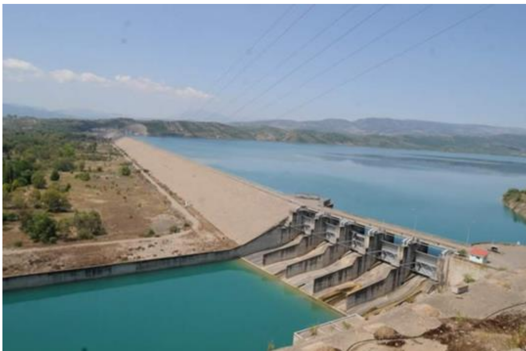
Εικόνα 6-2 Το φράγμα του Στράτου (πηγή: Διαδίκτυο)
