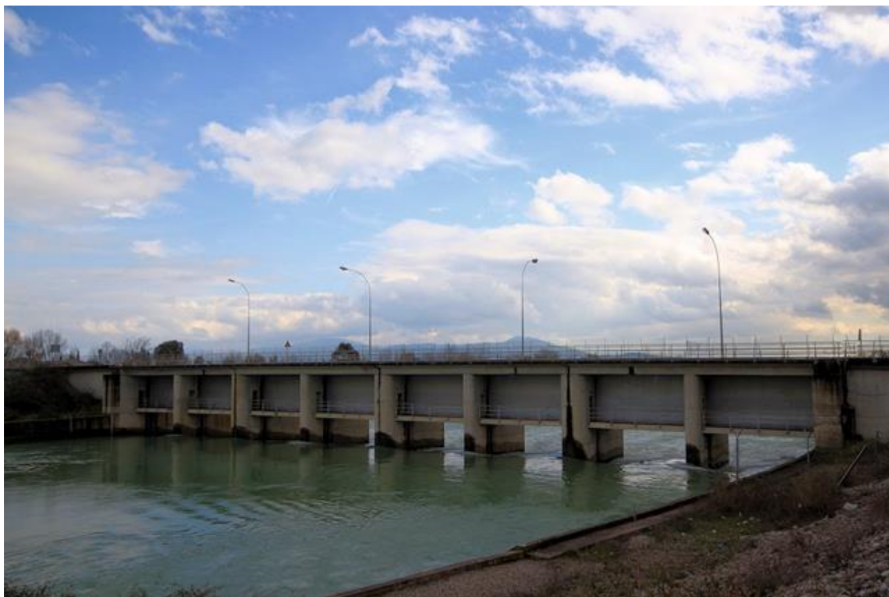
Εικόνα 6-55 Όψη έργου εξόδου διώρυγας φυγής από ανάντη (πηγή: Διαδίκτυο)
