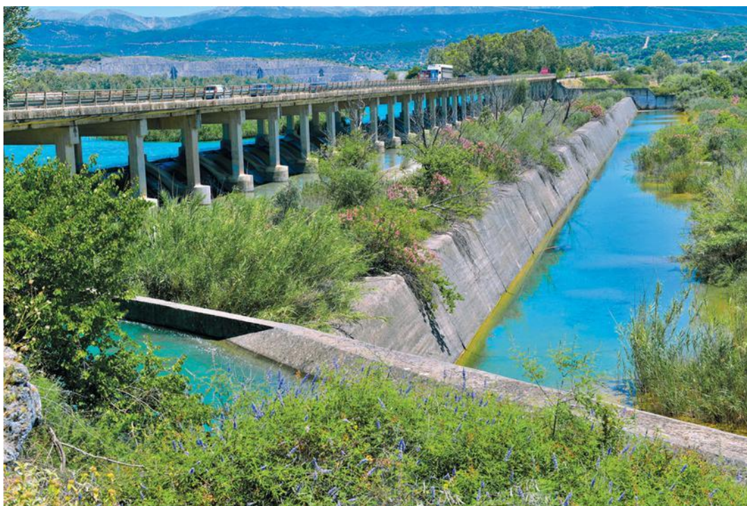
Εικόνα 6-3 Η γέφυρα του π. Αχελώου στο φράγμα του Στράτου, κατάντη της οποίας εκτείνεται η περιοχή μελέτης (πηγή: Διαδίκτυο)
