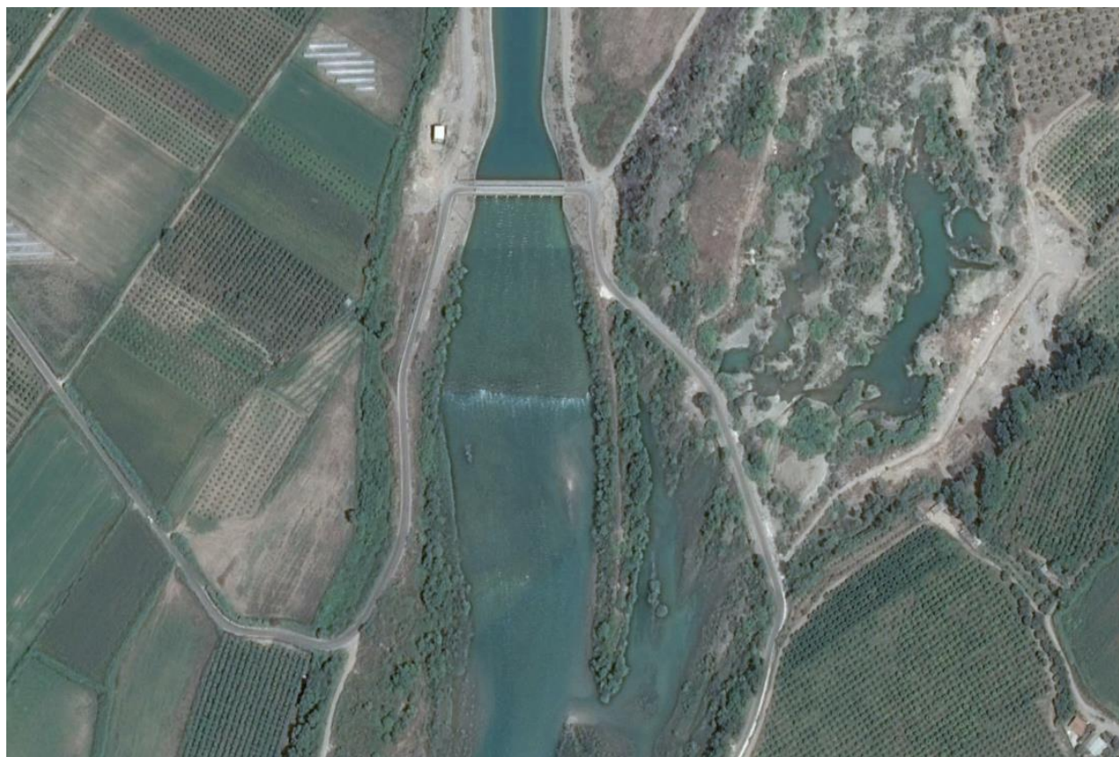
Εικόνα 6-15: Το έργο εξόδου της διώρυγας φυγής και η συμβολή με την παλαιά κοίτη του ποταμού (την κοίτη αμέσως κατάντη των υπερχειλιστών του φράγματος και έως την συμβολή με την διώρυγα) (πηγή: Google Earth)
