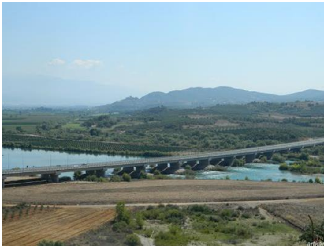
Εικόνα 6-47 Όψη γέφυρας Ιονίας οδού από ανάντη (πηγή: Google Earth)
