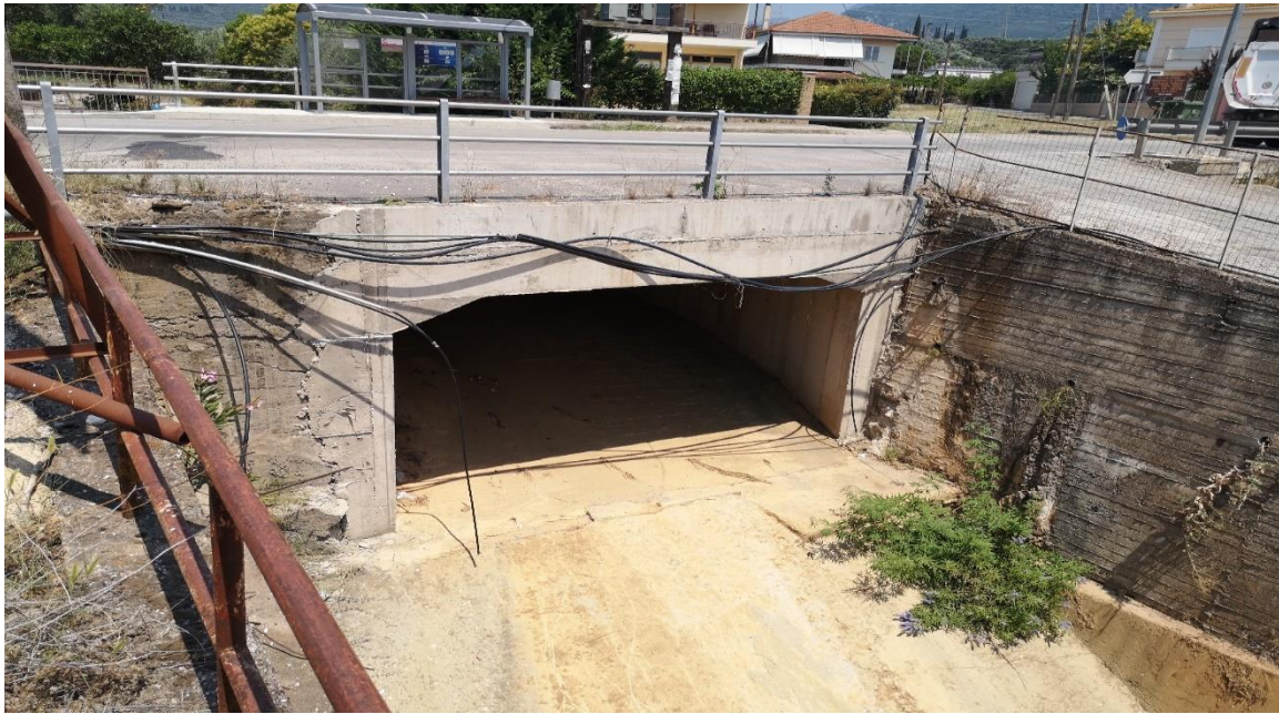
Φ 3-2 Καινούργιο, ανατολική είσοδος, Λιγόρεμα. Ανακατασκευασμένο τεχνικό, κατάντη άποψη.
