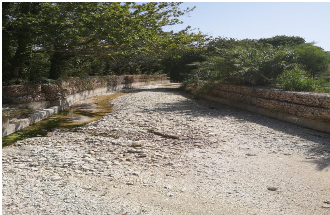
Φ 3-40 Ρουπακιάς κατάντη τεχνικού.
