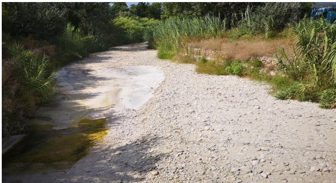
Φ 3-38 Σημειώνεται στένωση διατομής κατόπιν.
