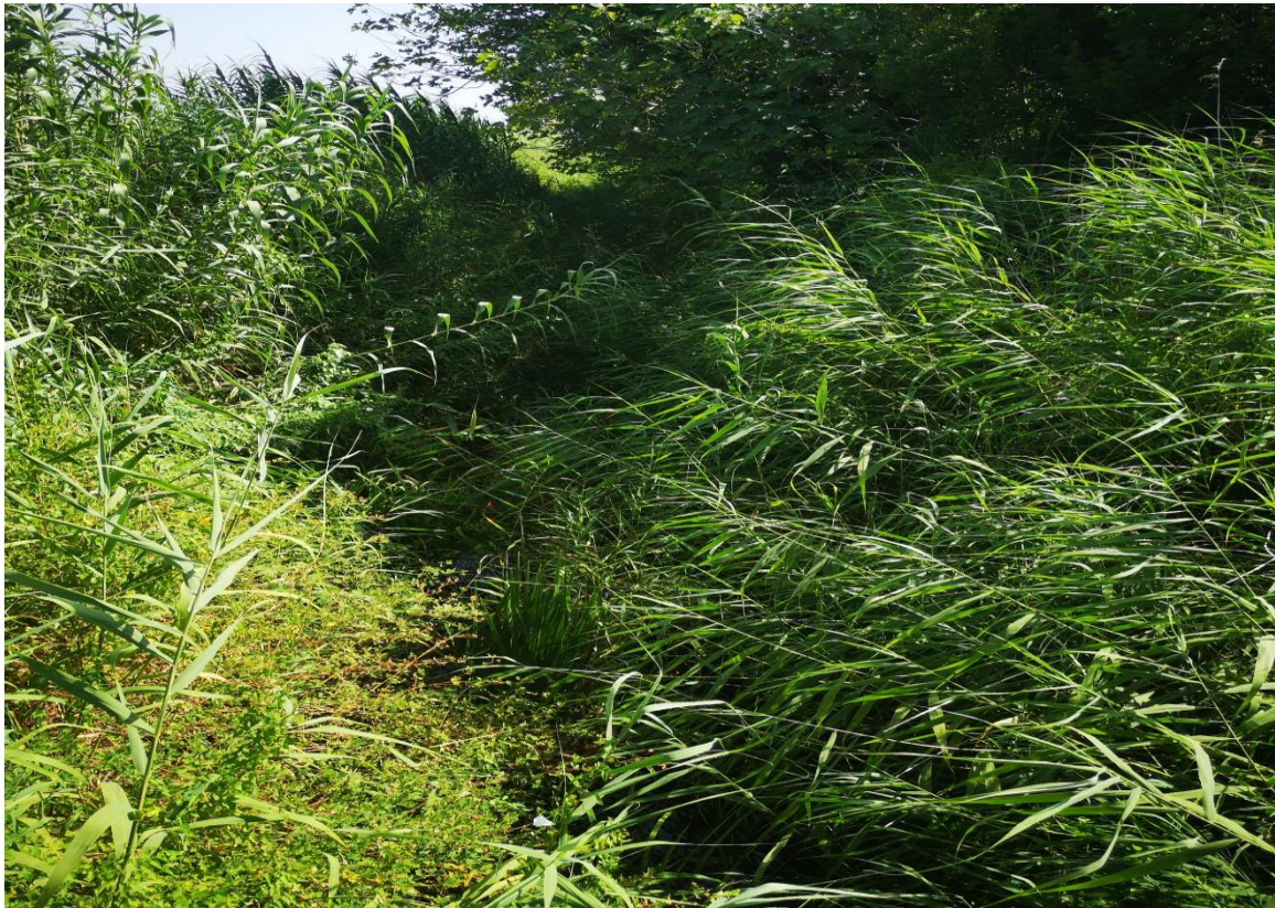
Φ 3-41 Τεχνικό σε άλλη θέση του ίδιου δρόμου. Κατάντη όψη.
