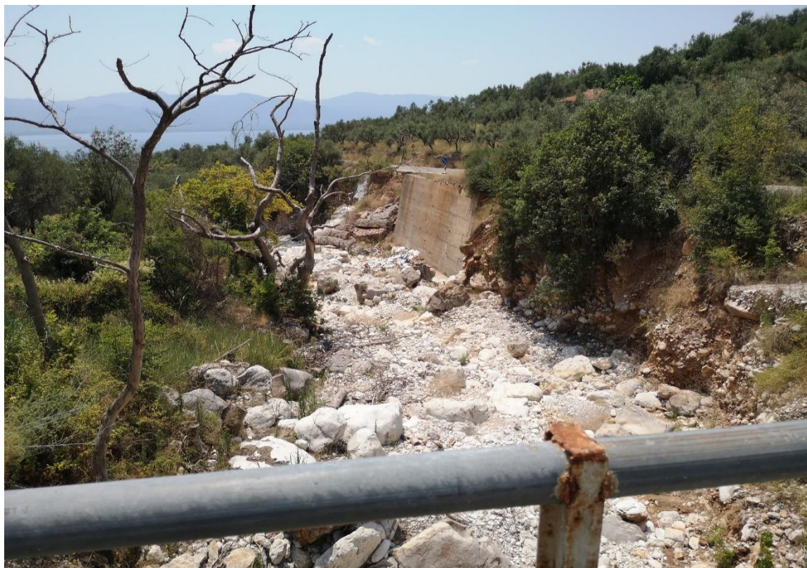
Φ 3-10 Ρέμα Κυρά Βγένας. Επαρχιακή Οδός Παραβόλας – Νερομάνας – Θέρμου. Όψη κατάντη
