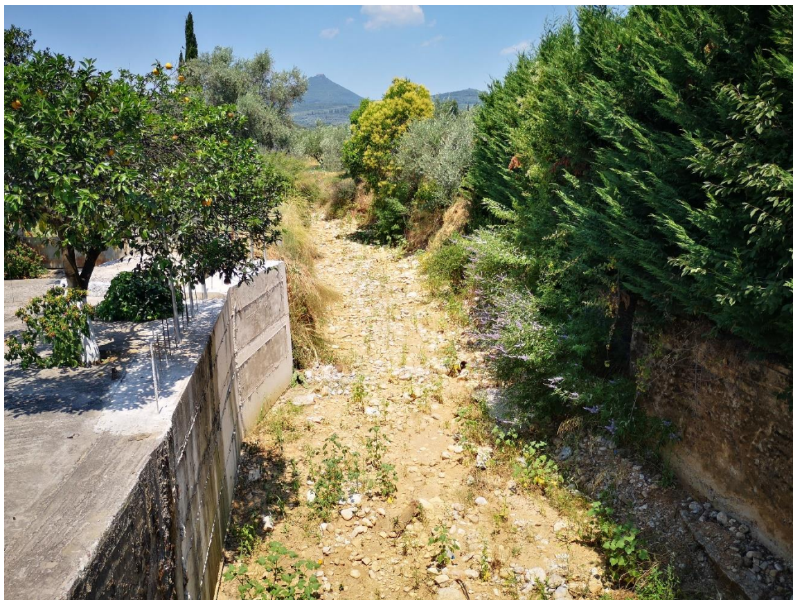
Φ 3-4 Καινούργιο. Άποψη ανάντη τεχνικού. Αριστερά διακρίνεται αυλή κατοικίας.
