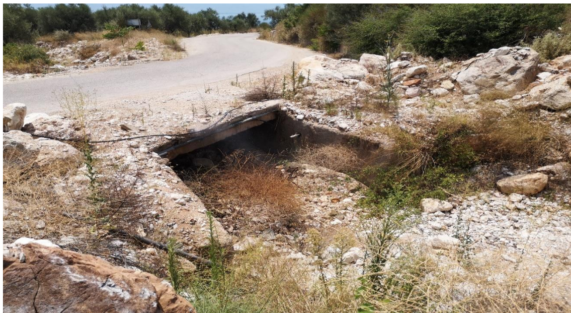
Φ 3-8 Ρέμα ανατολικά Παραβόλας. Η ανάντη είσοδος του οχετού, σχεδόν φραγμένη από φερτά.
