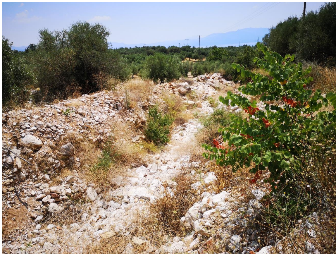
Φ 3-9 Ρέμα ανατολικά Παραβόλας. Αποψη προς κατάντη. Διακρίνονται φερτά που έχουν αποτεθεί αριστερά από παλαιότερο καθαρισμό.
