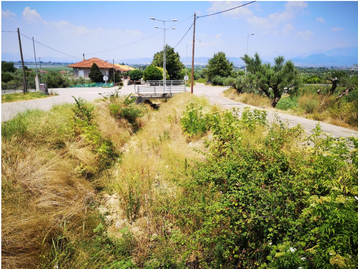
Φ 3-13 Ζευγαράκι Α. Επαρχιακή Οδός Ζευγαράκι – Κάτω Μακρινού. Διατομή επιχωμένη με φερτά. Ανεπαρκές τεχνικό.
