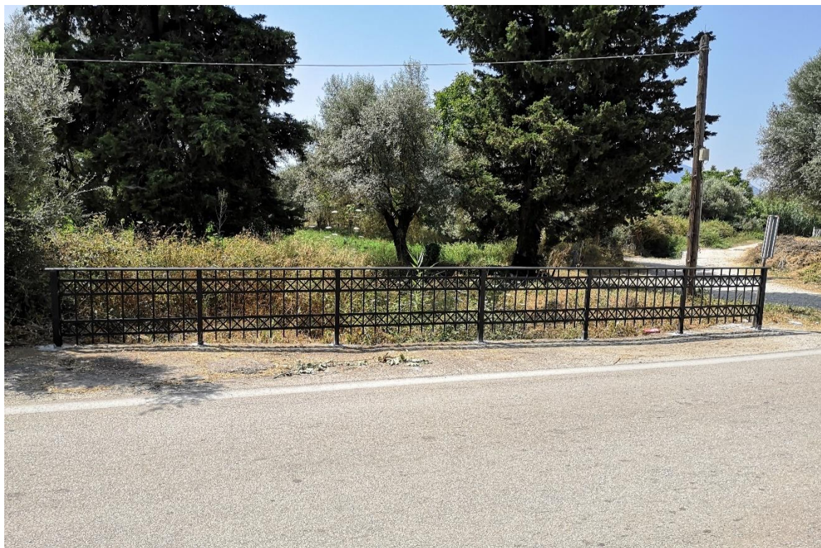
Φ 3-26 Τεχνικό σε ρέμα περιοχής Κανδήλας προς κατάντη, στη διασταύρωση με την οδό προς Βάρνακα
