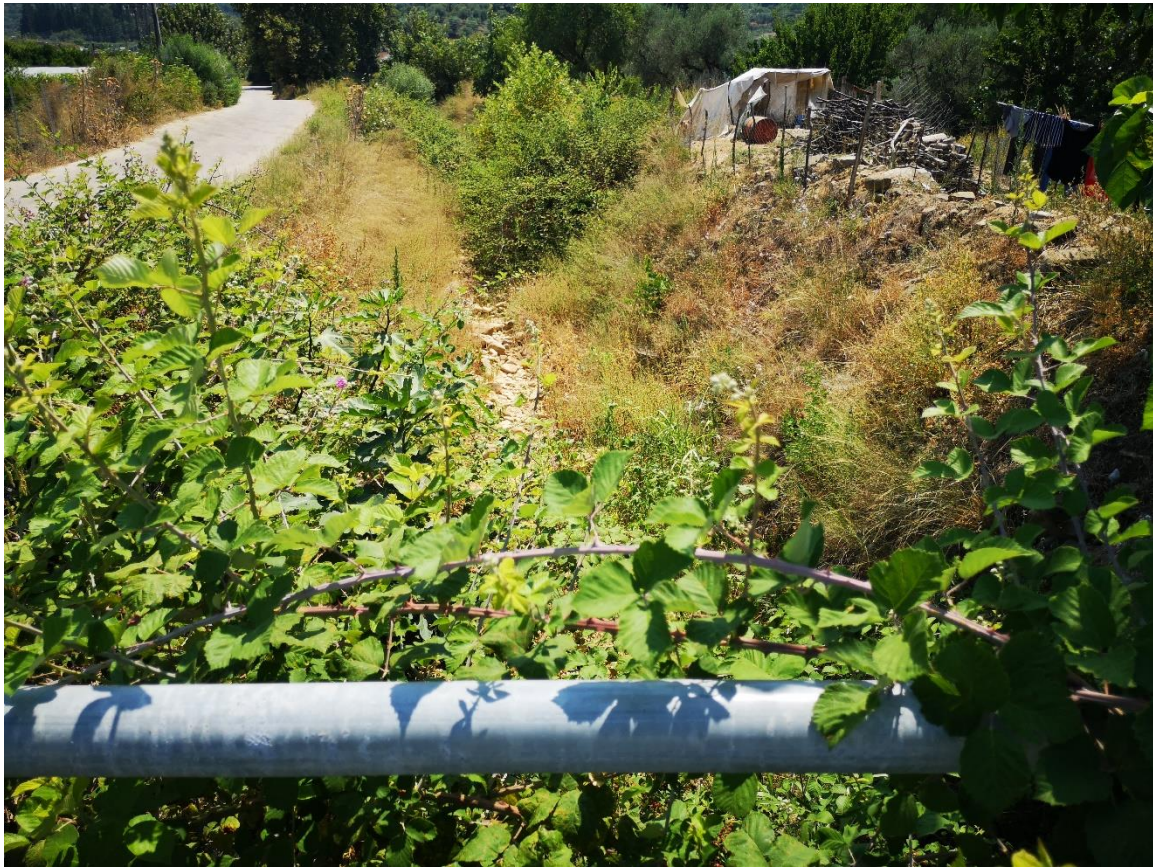
Φ 3-14 Ζευγαράκι Α. Επιχωμένη διατομή ανάντη. Έντονη βλάστηση.
