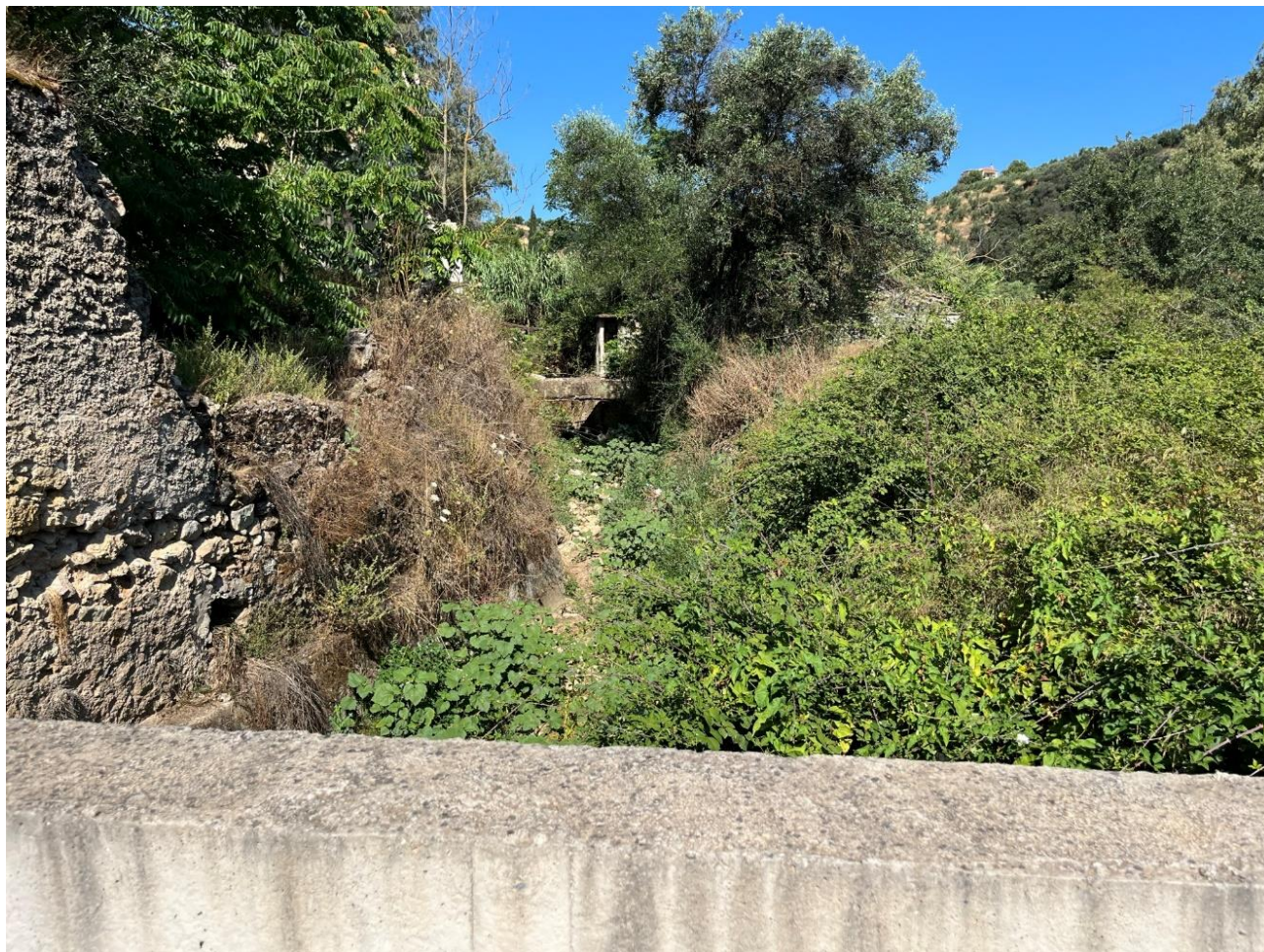
Φωτογραφία 3.56: Ρέμα Ξεριάς: Όψη ανάντη του διευθετημένου τμήματος που στο παρελθόν, λόγω ανεπαρκούς διατομής, φερτών και έντονης βλάστησης, υπερχείλισε (EL03_RH_45)
