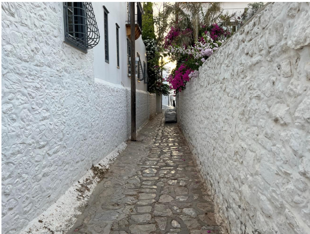
Φωτογραφία 3.50: Τυπική διατομή ρέματος-δρόμου μικρού πλάτους, 200m κατάντη του προηγούμενου σημείου, εντός της πόλης της Ύδρας (EL03_PH_39)
