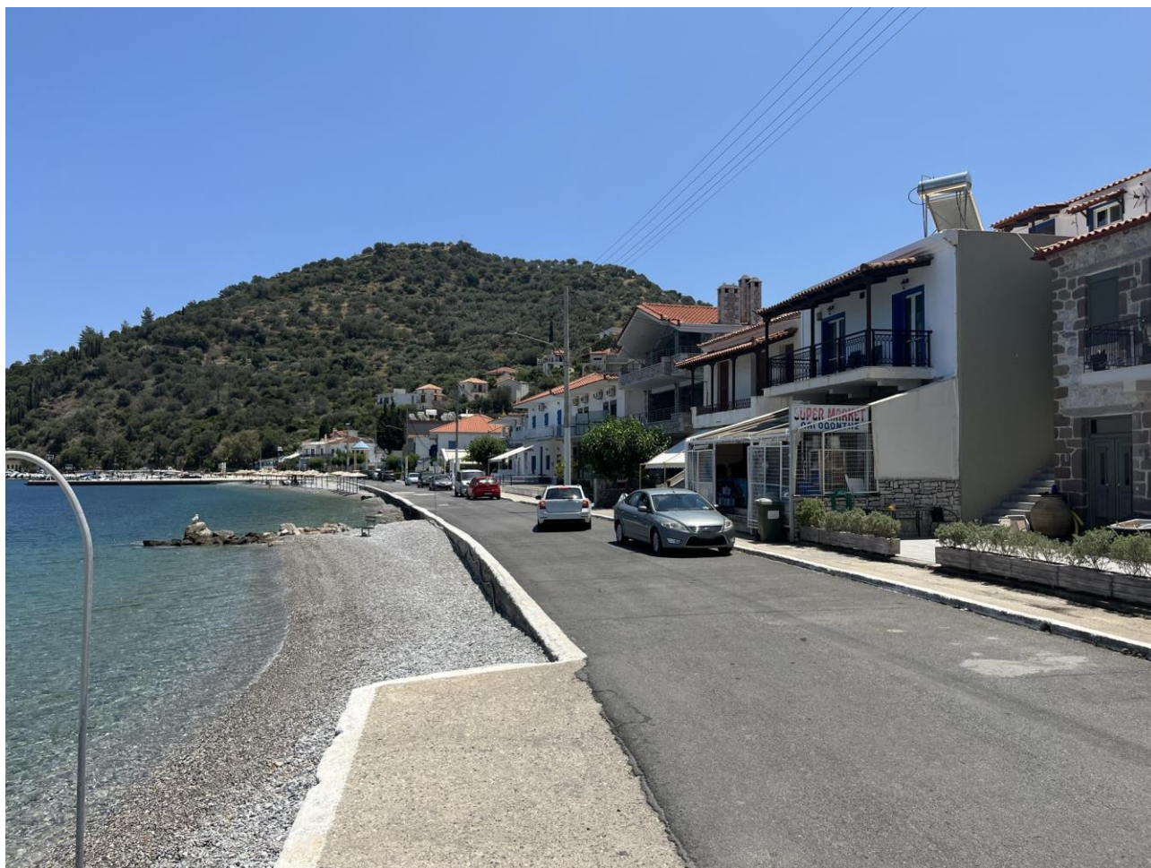
Φωτογραφία 3.7: Διακρίνεται η πολύ μικρή υψομετρική διαφορά του παραλιακού δρόμου από την ακτογραμμή, με αποτέλεσμα σε περιόδους έντονου κυματισμού να κατακλύζεται ο δρόμος και κάποιες παρόδιες κατοικίες (EL03_PH_03)
