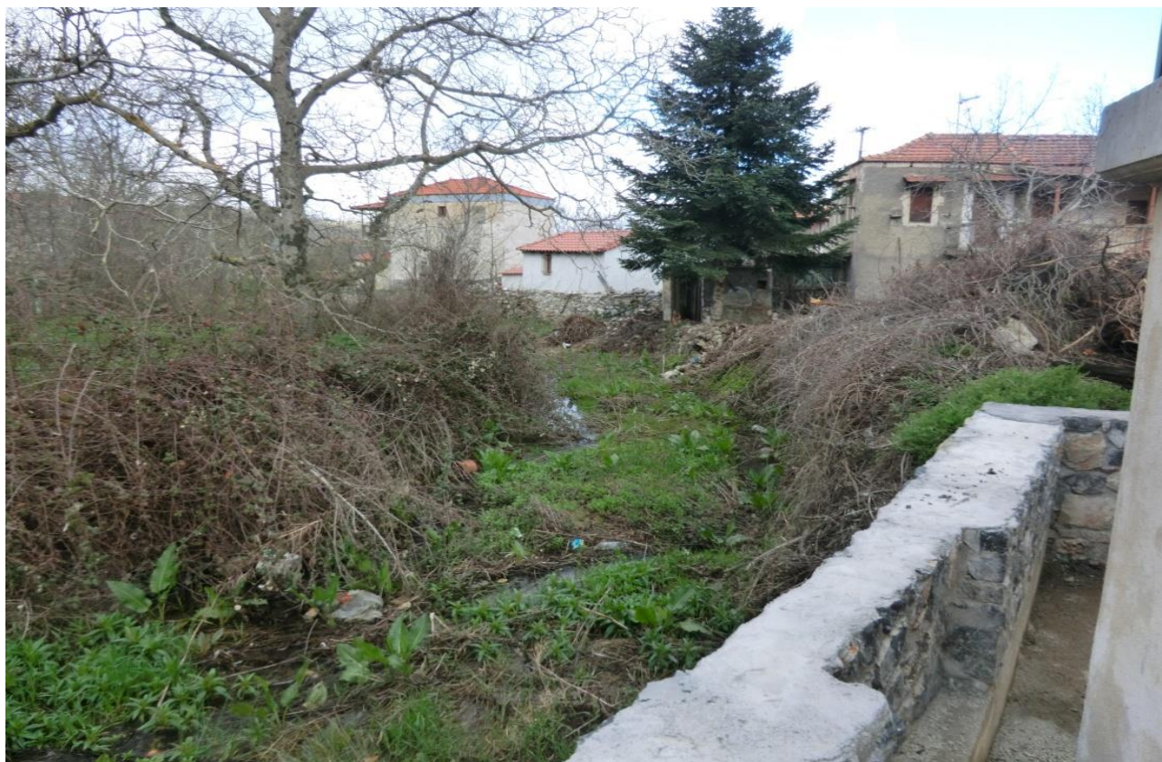
Φωτογραφία 3.15: Τεχνικό ρέματος εντός οικισμού Βερβένων (ΕΛ03_PΗ_11)
