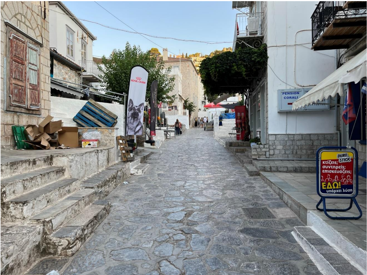
Φωτογραφία 3.47: Διατομή εντός του οικισμού της Ύδρας με διπλό ρόλο: δρόμου και ανοιχτού αγωγού αποχέτευσης ομβρίων υδάτων (EL03_PH_36)
