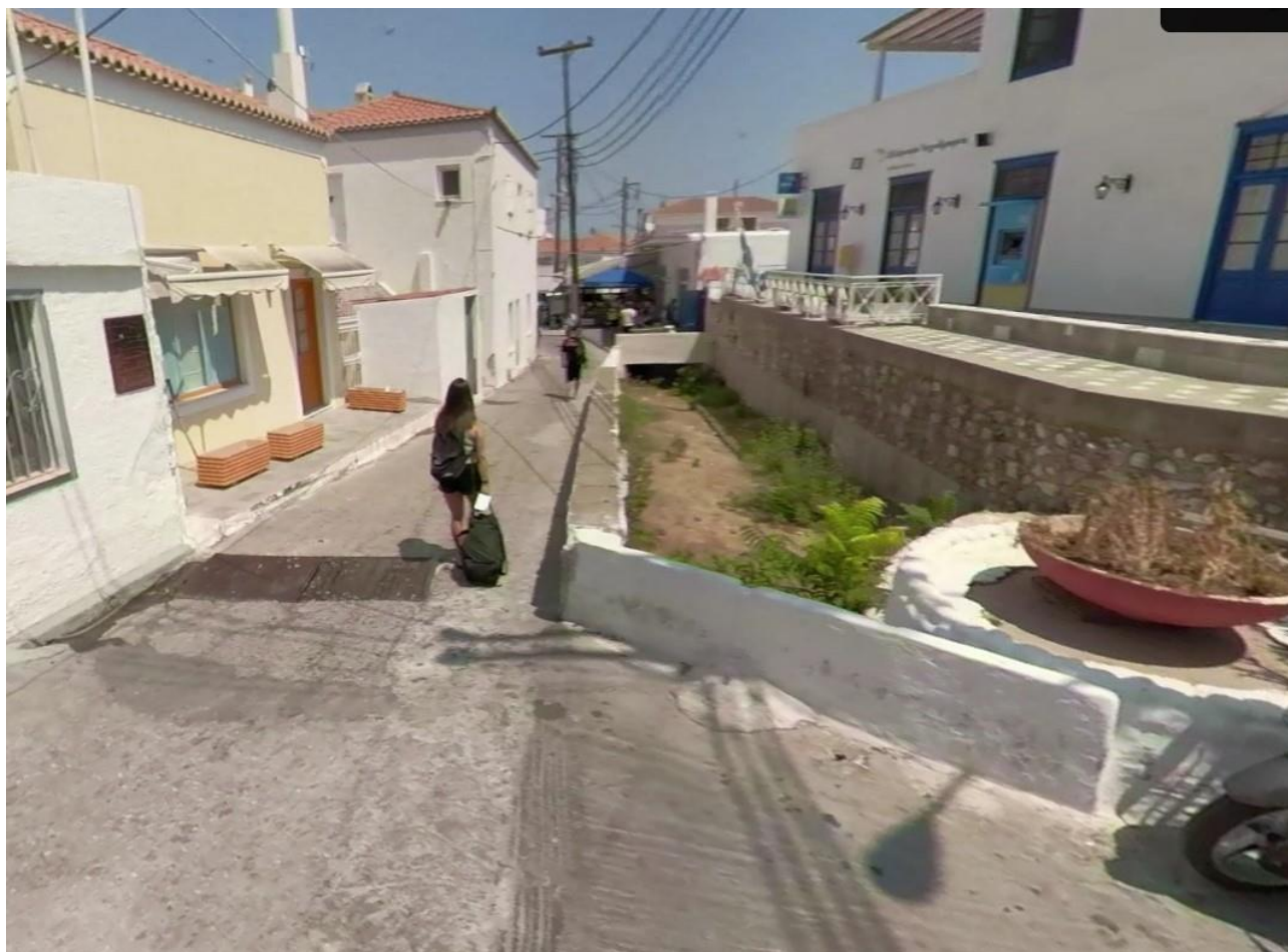
Φωτογραφία 3.24: Κατάντη όψη τεχνικού εντός της πόλης των Σπετσών, 120m ανάντη της εκβολής του ρέματος 3. Διακρίνεται το μερικώς 'μπαζωμένο' πέρασμα-γεφύρι (EL03_PH_17)
