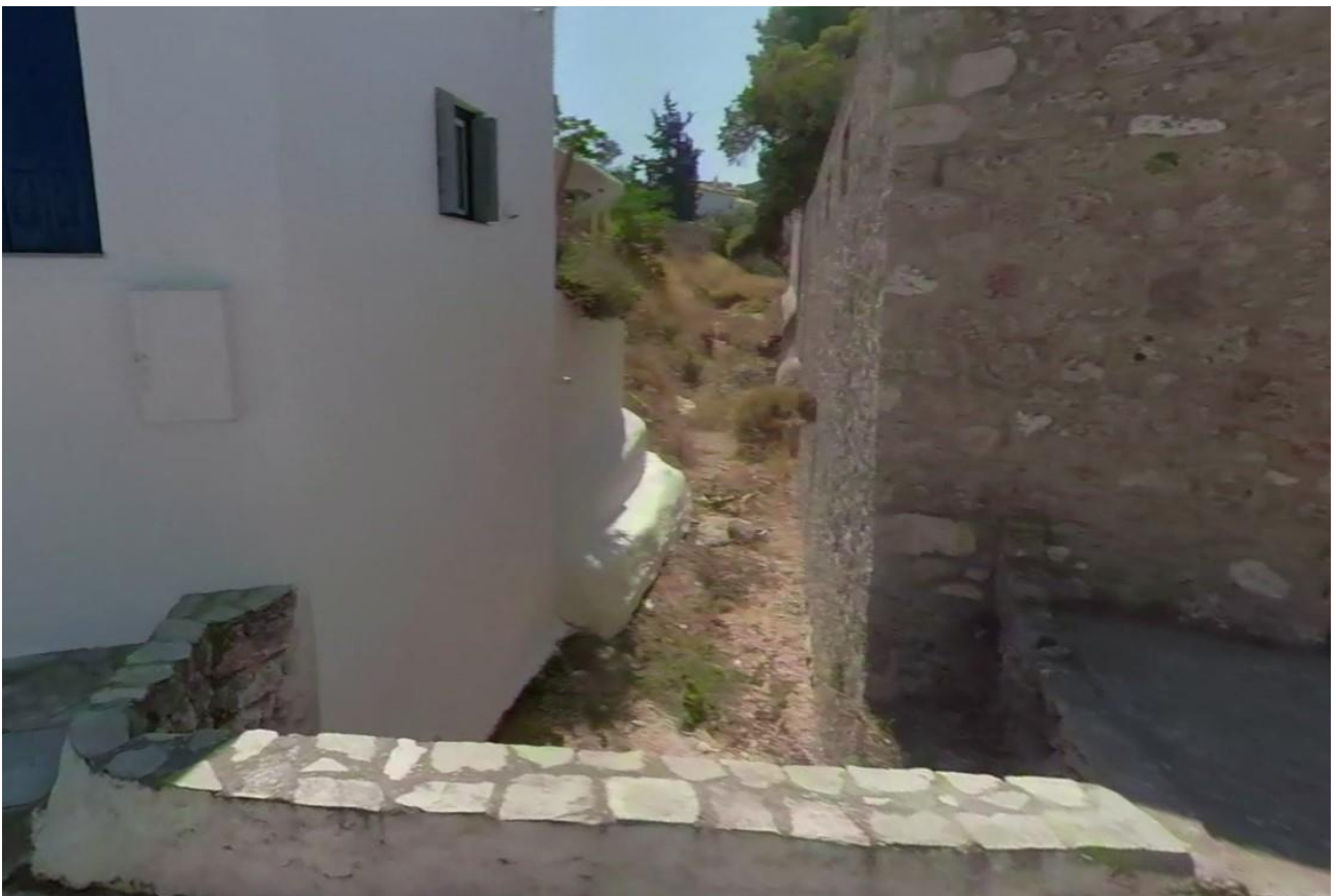
Φωτογραφία 3.29: Ανάντη όψη τεχνικού του ρέματος 4 εντός της πόλης των Σπετσών, επί της διασταύρωσης των οδών Ορλάνδου-Μπαρμπάτση (EL03_PH_22)
