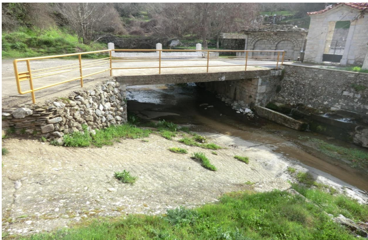
Φωτογραφία 3.14: Τεχνικό ρέματος εντός οικισμού Βερβένων (ΕΛ03_PH_10)
