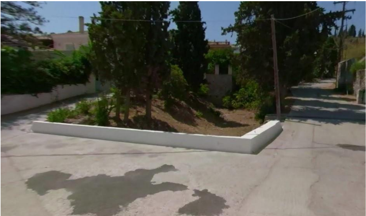
Φωτογραφία 3.33: Διακρίνεται το ανάντη μέρος του τεχνικού του ρέματος 5 στο άνω όριο του οικισμού (EL03_PH_26)
