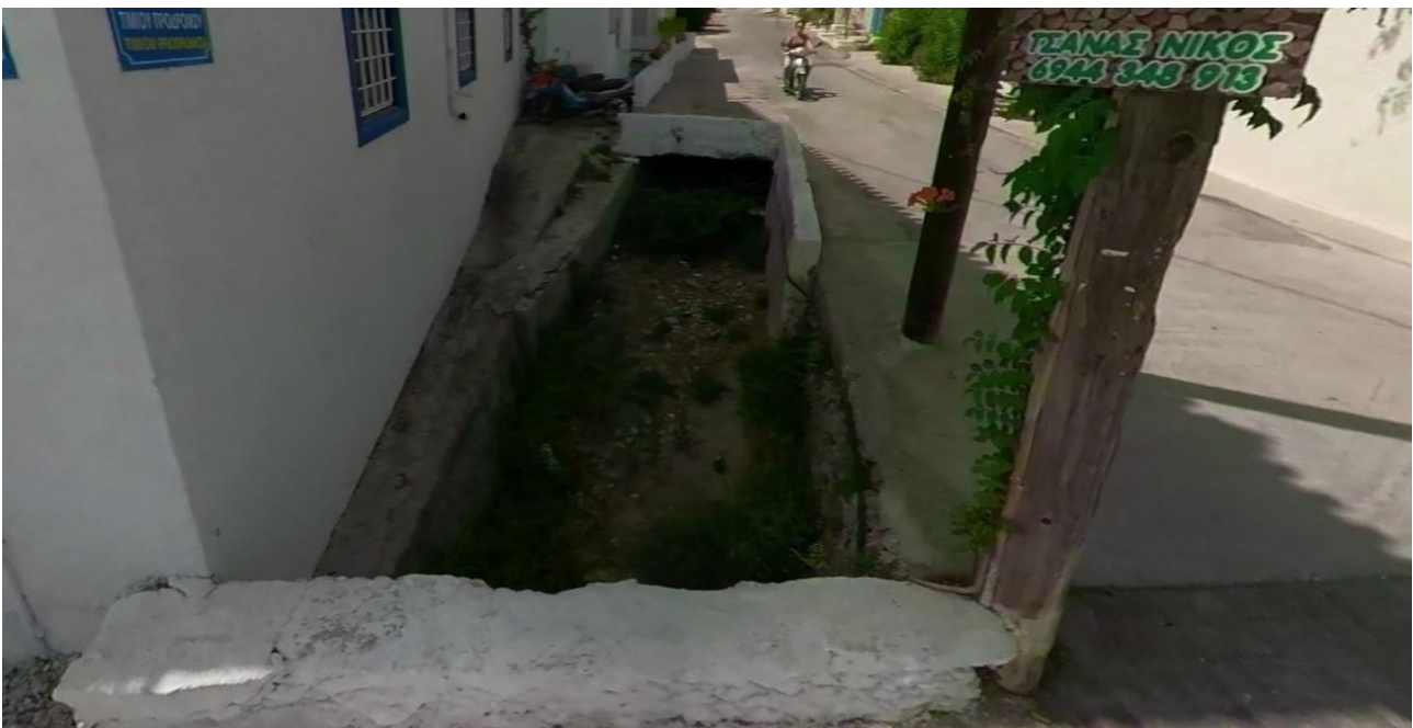
Φωτογραφία 3.36: Διακρίνεται το ανάντη μέρος της εκβολής του ρέματος 5 στη θάλασσα που γειτνιάζει με ιδιοκτησίες και έχει υποστεί παρεμβάσεις (EL03_PH_29)
