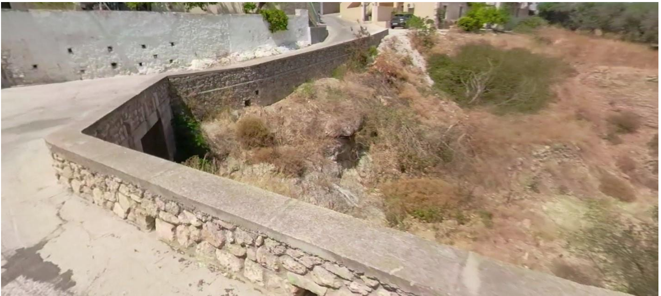
Φωτογραφία 3.28: Κατάντη όψη τεχνικού του ρέματος 4 εντός της πόλης των Σπετσών. Το ρέμα κατάντη του τεχνικού έχει φυσική ροή (χωρίς παρεμβάσεις) (EL03_PH_21)
