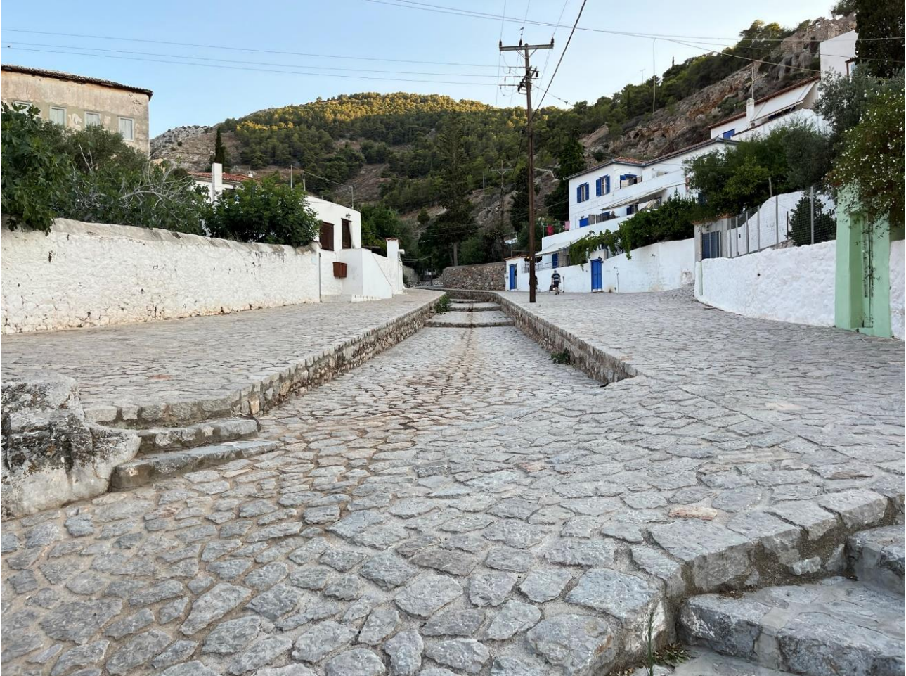
Φωτογραφία 3.45: Διατομή εντός του οικισμού της Ύδρας με διπλό ρόλο: δρόμου και ανοιχτού αγωγού αποχέτευσης ομβρίων υδάτων (EL03_PH_34)
