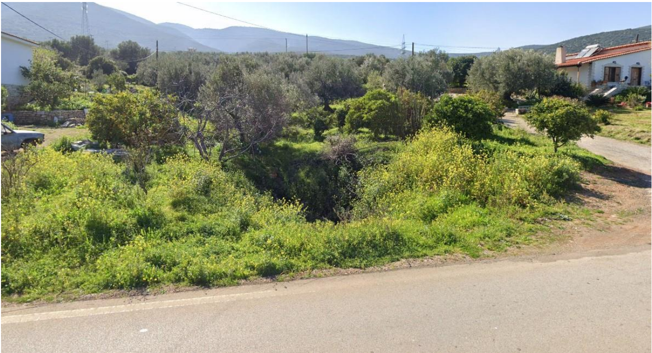
Φωτογραφία 3.8: Ανάντη όψη τεχνικού επί της επαρχιακής οδού Κιβερίου – Άστρους, χωριό Ξηροπήγαδο (ΕΛ03_PΗ_04)
