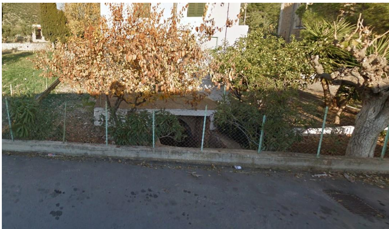
Φωτογραφία 3.53: Ανάντη όψη ρέματος πριν διασχίσει την Επ. Οδό Σπάρτης-Αγ. Δημητρίου και εισέλθει στο δίκτυο ομβρίων (EL03_PH_42)
