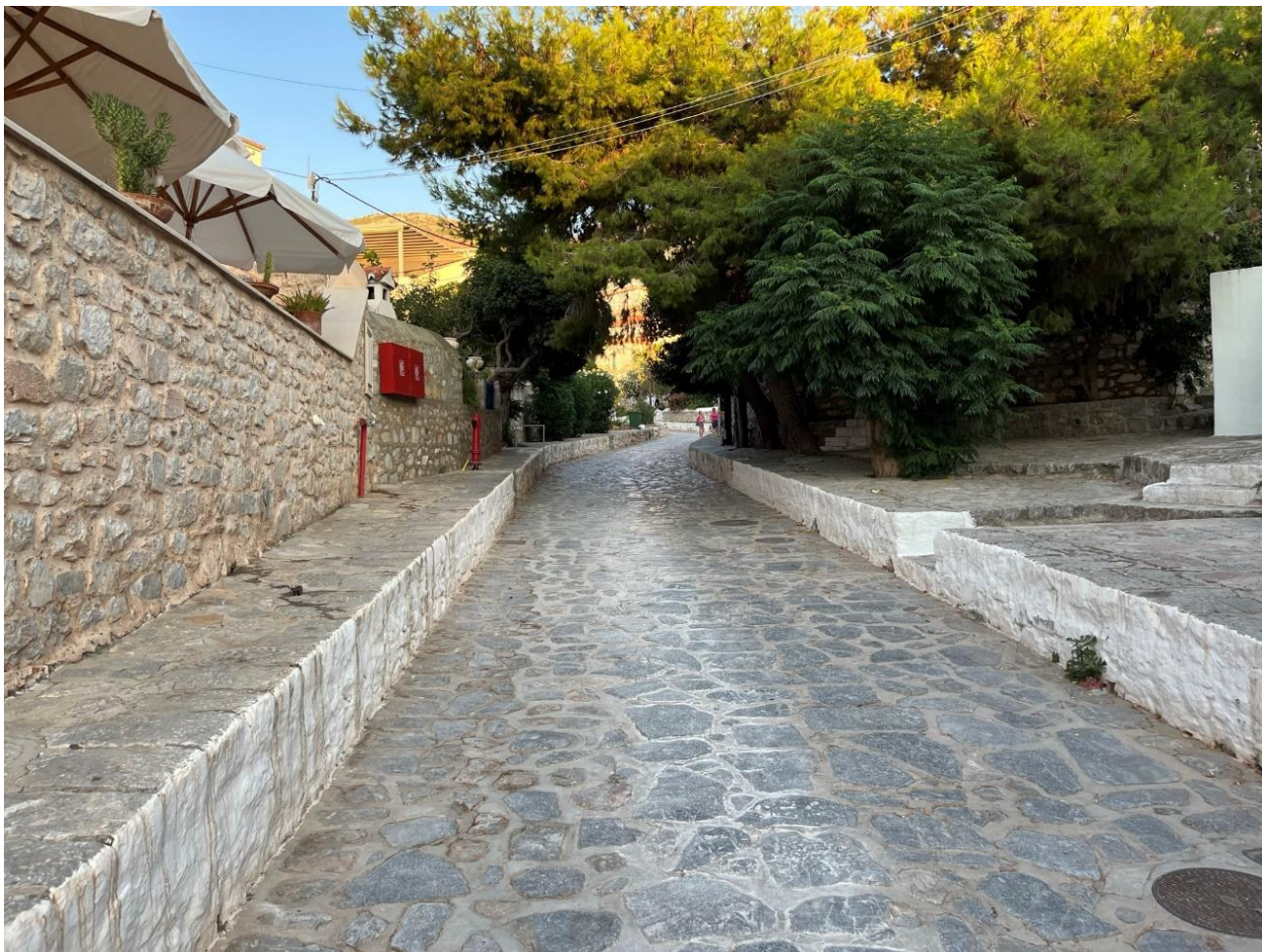
Φωτογραφία 3.46: Διατομή εντός του οικισμού της Ύδρας με διπλό ρόλο: δρόμου και ανοιχτού αγωγού αποχέτευσης ομβρίων υδάτων (EL03_PH_35)
