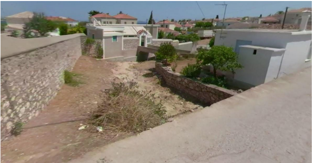
Φωτογραφία 3.35: Διακρίνεται το κατάντη μέρος του ρέματος 5, 100m ανάντη της εκβολής. Παρατηρείται εκτροπή της φυσικής ροής του ρέματος λόγω πυκνής δόμησης (EL03_PH_28)
