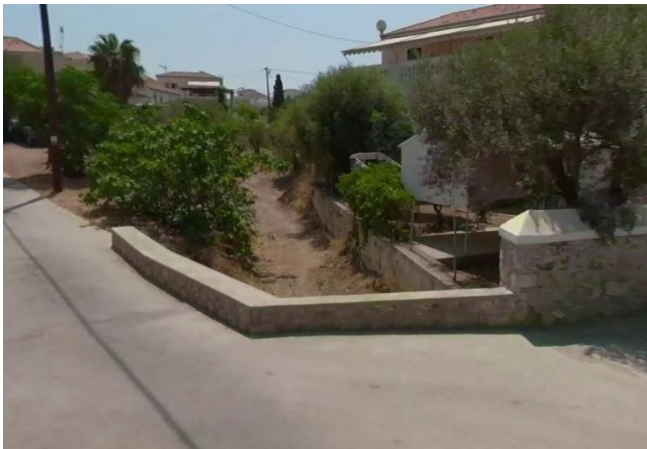
Φωτογραφία 3.19: Ανάντη όψη τεχνικού εντός της πόλης των Σπετσών, 300m ανάντη της εκβολής του ρέματος 2 (EL03_PH_12)
