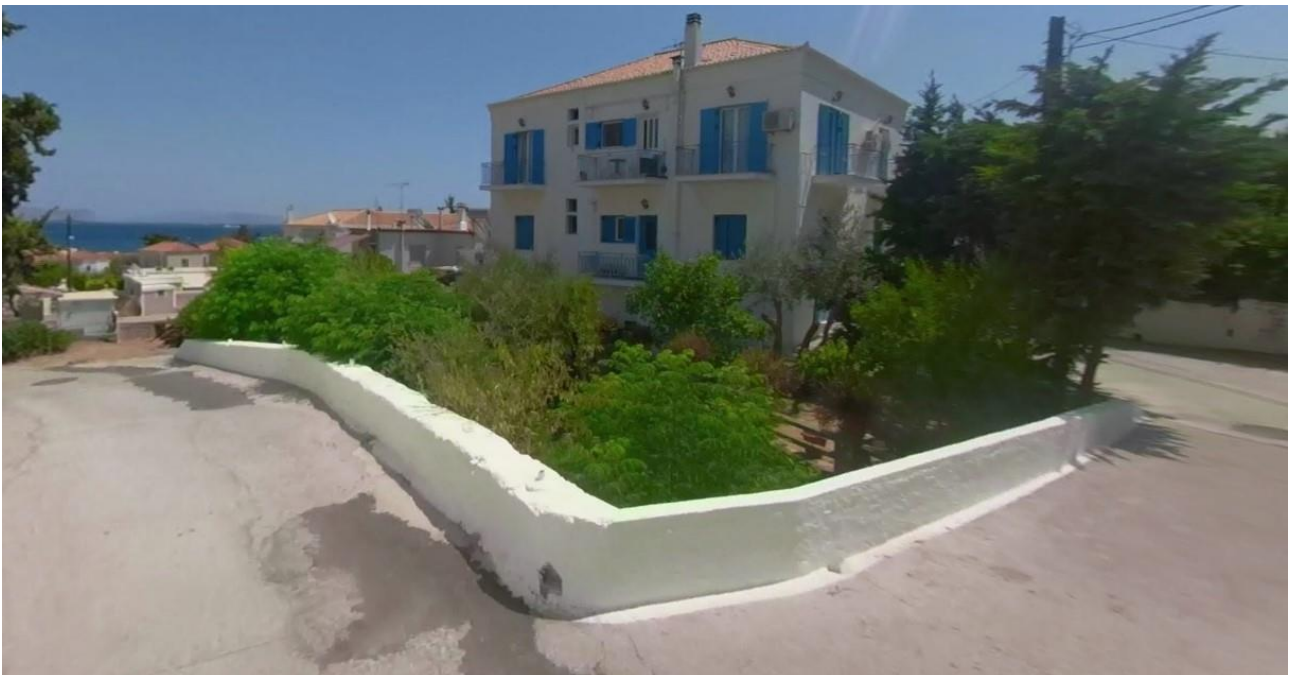
Φωτογραφία 3.32: Το κατάντη μέρος του τεχνικού του ρέματος 5 στο άνω όριο του οικισμού. Διακρίνεται η έντονη βλάστηση εντός της κοίτης (EL03_PH_25)
