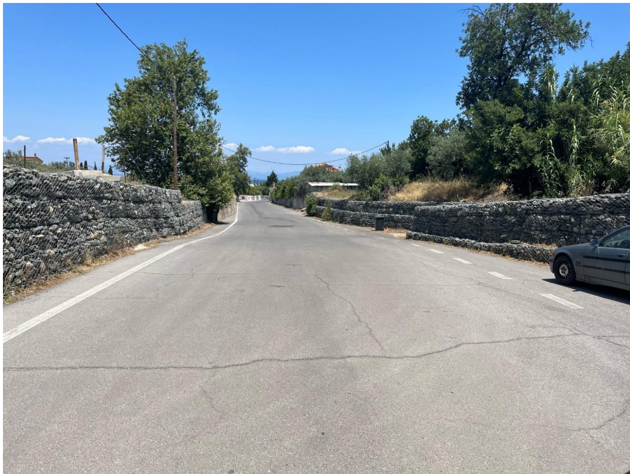
Φωτογραφία 3.2: Οδός στον οικισμό Τυρό όπου ανάντη του διέρχεται υδατόρεμα (EL03_PH_01)
