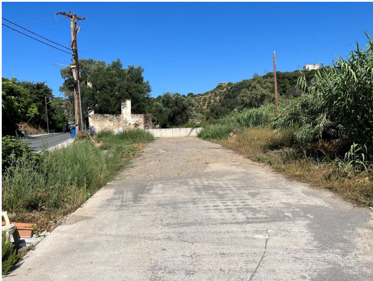
Φωτογραφία 3.55: Ρέμα Ξεριάς: Διακρίνεται το τελευταίο ανάντη διευθετημένο τμήμα του στην είσοδο του Γυθείου και ο τοίχος που κατασκευάσθηκε εκ των υστέρων για να αποφευχθούν υπερχειλίσεις (EL03_PH_44)
