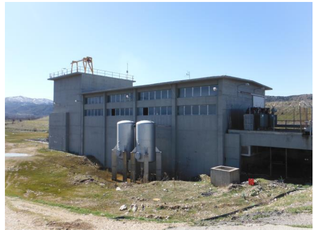
Φωτογραφία 9.16: Αντλιοστάσιο χαμηλής περιοχής γύρω από τη Λίμνη Τάκα
