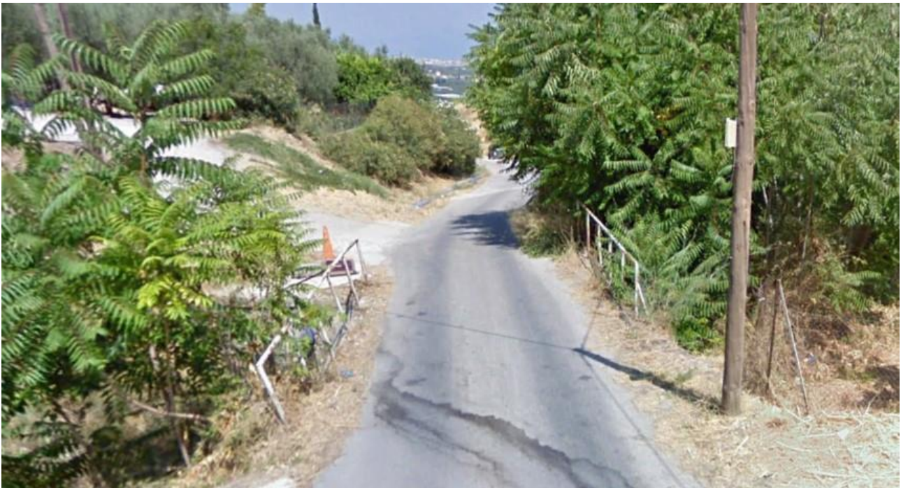
Φωτογραφία 3.2: Τεχνικό διέλευσης ρέματος 50m ανάντη της Ολυμπίας Οδού στο ύψος της Νέας Κερύνειας (EL02_PH_01)
