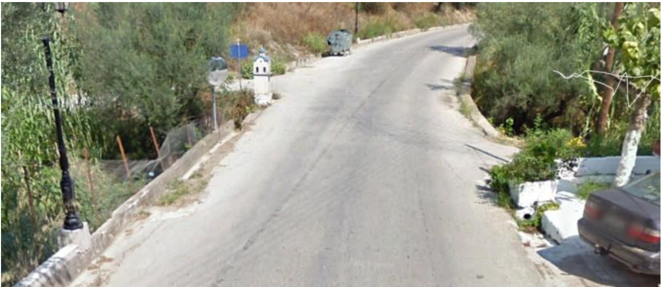
Φωτογραφία 3.7: Τεχνικό, επί της επαρχιακή οδού Σελινιάτικα-Βερίνου, λίγο πριν τη συμβολή του ρέματος 2 με Θολοπόταμο (EL02_PH_05)
