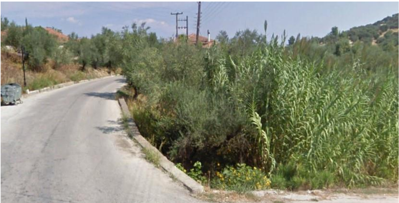
Φωτογραφία 3.8: Κατάντη όψη τεχνικού, επί της επαρχιακή οδού Σελινιάτικα-Βερίνου, του ρέματος 2 με έντονη βλάστηση (EL02_PH_06)
