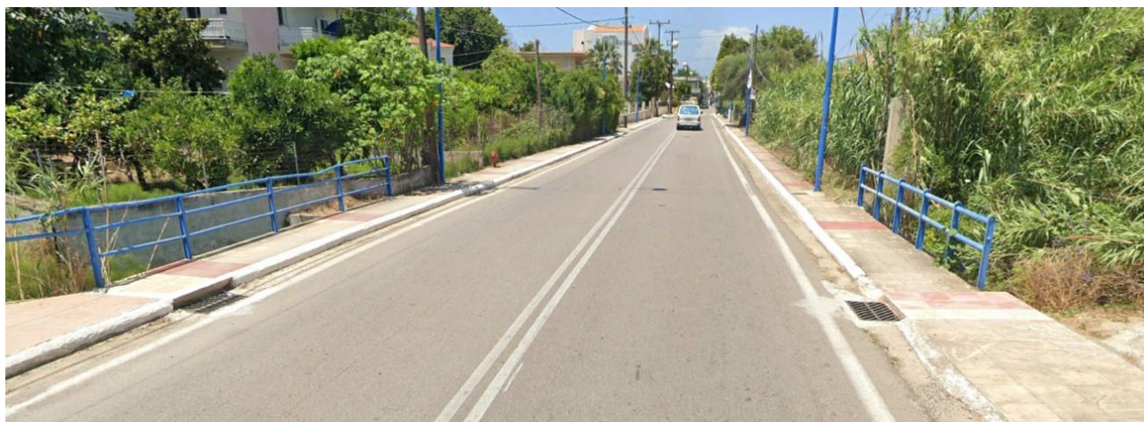
Φωτογραφία 3.18: Ρέμα βόρεια του οικισμού της Κάτω Παναγιάς. Διακρίνεται η ανάγκη καθαρισμού της κοίτης από την έντονη βλάστηση (EL02_PH_10)
