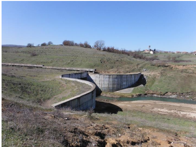
Φωτογραφία 9.10: Είσοδος τεχνικού κάλυψης Αλφειού στην περιοχή Τριποτάμου.
