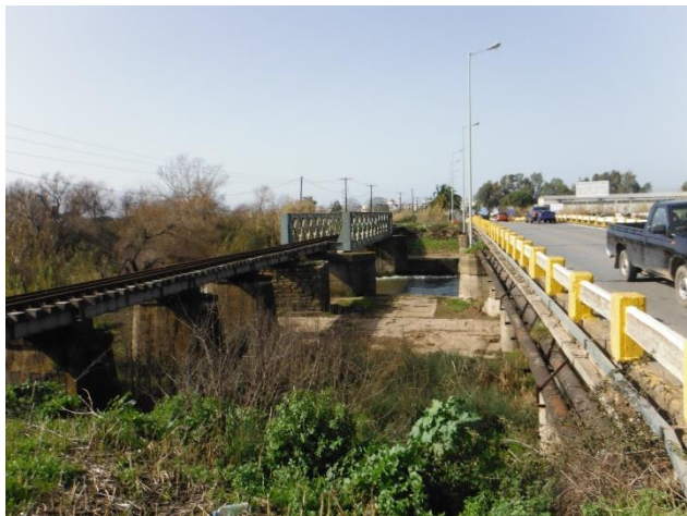
Φωτογραφία 9.3: Οδική και σιδηροδρομική γέφυρα Πάμισου επί διευθετημένης κοίτης.
