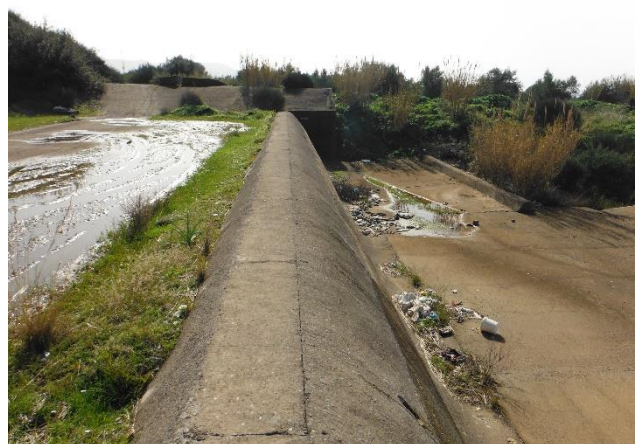
Φωτογραφία 9.9: Φράγμα Χ. Ξερίλα.
