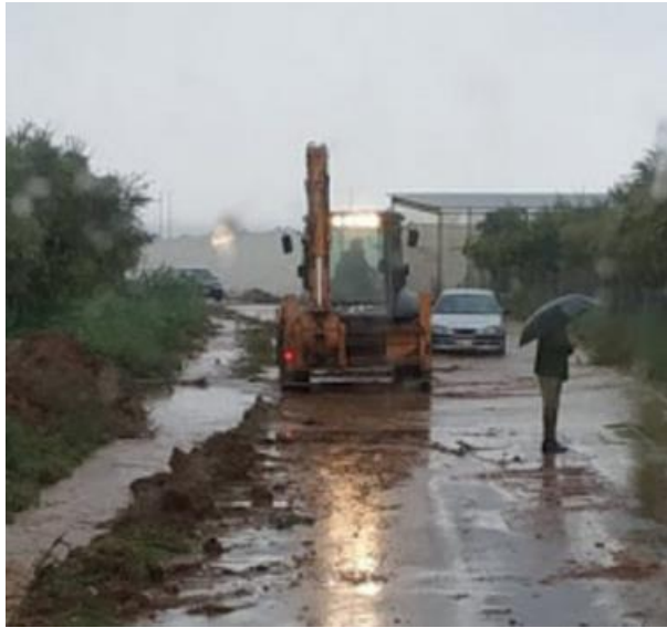
Φωτογραφία 9.18: Εθνικός δρόμος Κυπαρισσίας-Φιλιατρών
