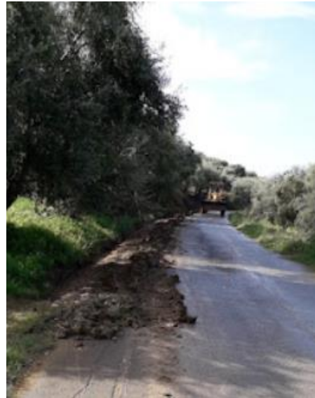
Φωτογραφία 9.19: Εθνικός δρόμος Κυπαρισσίας-Φιλιατρών
