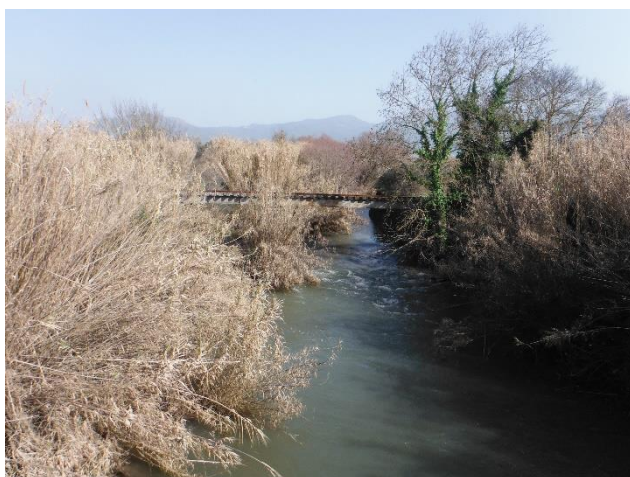
Φωτογραφία 9.8: Χ. Μαυροζούμενα, Σιδηροδρομική γέφυρα ανάντη Μελιγαλά.
