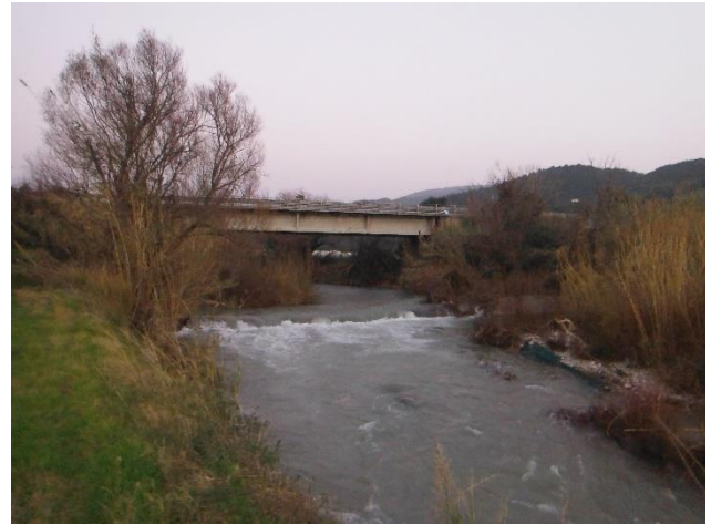
Φωτογραφία 9.17: Π. Νέδα. Τεχνικό Επαρχιακής Οδού Πύργου - Κυπαρισσίας
