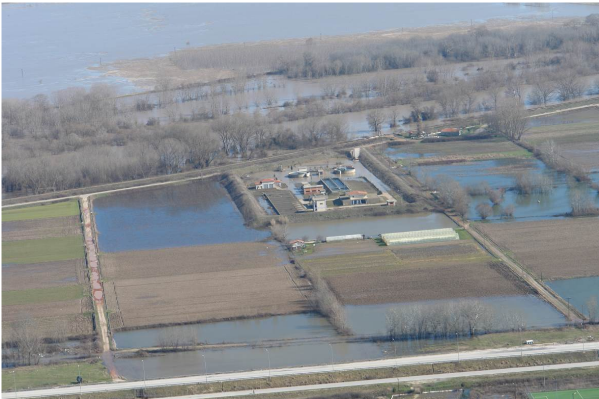
Εικόνα 8.6 ΕΕΛ Διδυμοτείχου (πάνω) και Σουφλίου (κάτω), 19/02/2010 (Πηγή: Γ. Τσεσμελής)
