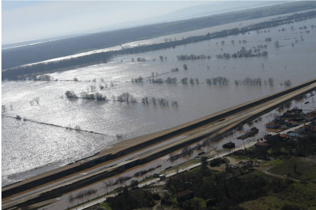
Εικόνα 3.9 Ο κάθετος άξονας υπό κατασκευή στα Λάβαρα κατά τις πλημμύρες του 2010.
