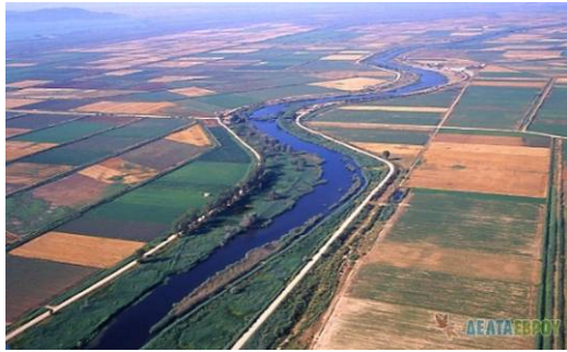
Αεροφωτογραφία Δυτικού Βραχίονα
