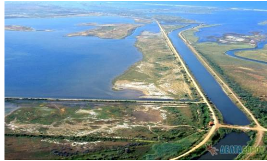
Αεροφωτογραφία της λιμνοθάλασσας Δράνας
