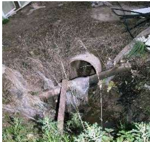
Σχήμα 7.7: Ρέμα Σαραντάρης που εγκλωβίζεται στον εικονιζόμενο αγωγό
