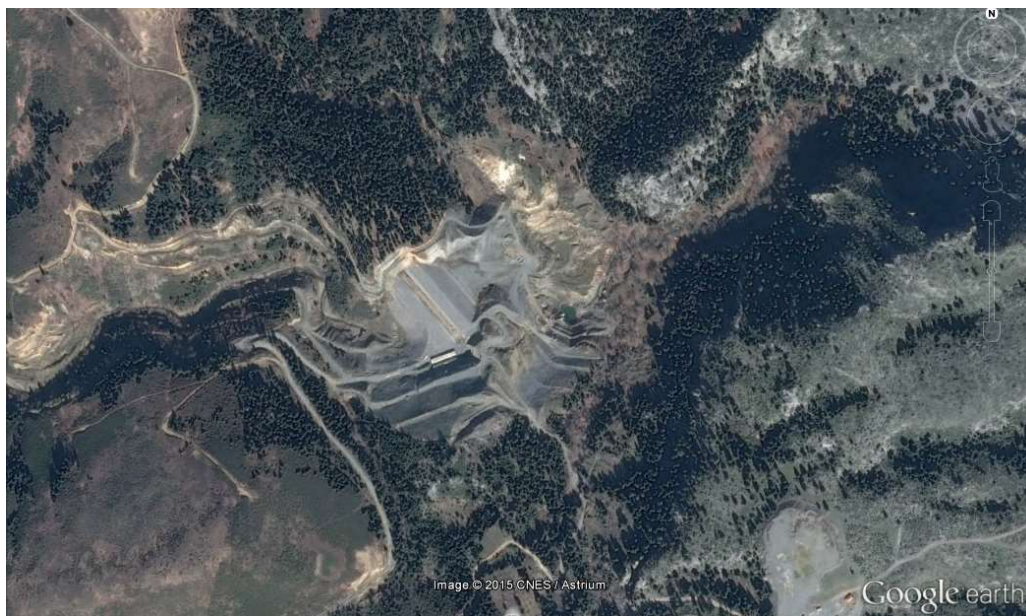
Σχήμα 7.29: Φράγμα Σέττας - Μανικίων (πηγή: Google earth)
