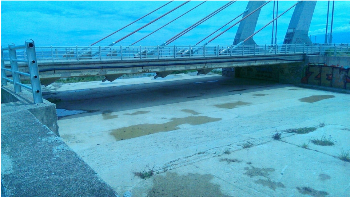
Φωτ. 4: Η ΝΕΑ ΓΕΦΥΡΑ ΣΤΗΝ ΕΚΒΟΛΗ ΤΟΥ ΧΕΙΜΑΡΡΟΥ ΑΓΙΟΚΑΜΠΟΥ
