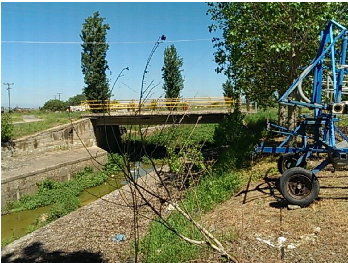
Φωτ. 6: ΝΕΟ ΜΟΝΑΣΤΗΡΙ. ΓΕΦΥΡΑ ΣΤΟΝ Χ. ΚΑΚΑΡΑ. Η ΑΝΑΝΤΗ ΔΙΑΤΟΜΗ ΕΙΝΑΙ ΕΠΕΝΔΕΔΥΜΕΝΗ, Η ΚΑΤΑΝΤΗ ΟΧΙ.
