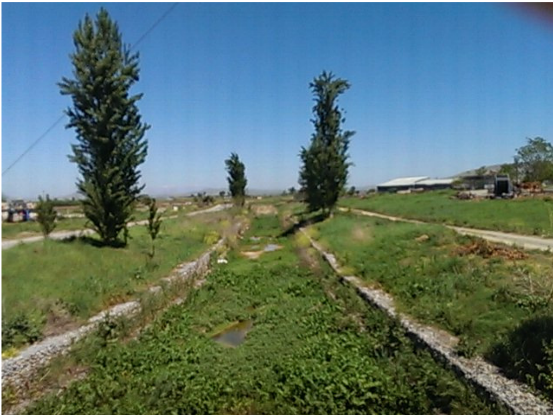
Φωτ. 8: Π. ΚΑΚΑΡΑΣ. ΑΝΕΠΕΝΔΥΤΗ ΔΙΑΤΟΜΗ ΚΑΤΑΝΤΗ ΤΗΣ ΓΕΦΥΡΑΣ ΜΕ ΣΥΡΜΑΤΟΚΙΒΩΤΙΑ ΑΡΙΣΤΕΡΑ – ΔΕΞΙΑ.
