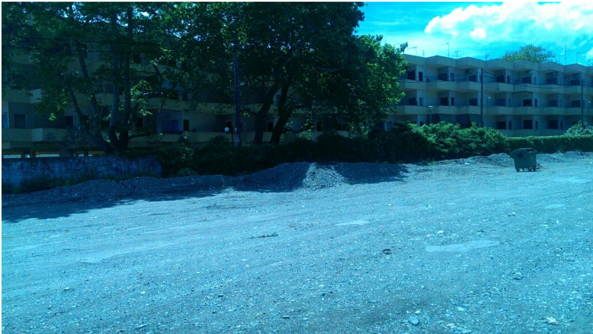
Φωτ. 1: Η ΚΟΙΤΗ ΤΟΥ ΧΕΙΜΑΡΡΟΥ ΚΟΝΤΑ ΣΤΗΝ ΕΚΒΟΛΗ ΣΤΗΝ ΘΑΛΑΣΣΑ. ΔΙΑΚΡΙΝΕΤΑΙ Ο ΤΟΙΧΟΣ ΠΡΟΣΤΑΣΙΑΣ ΤΗΣ «ΠΟΛΥΚΑΤΟΙΚΙΑΣ ΤΩΝ ΗΛΕΚΤΡΟΛΟΓΩΝ».
