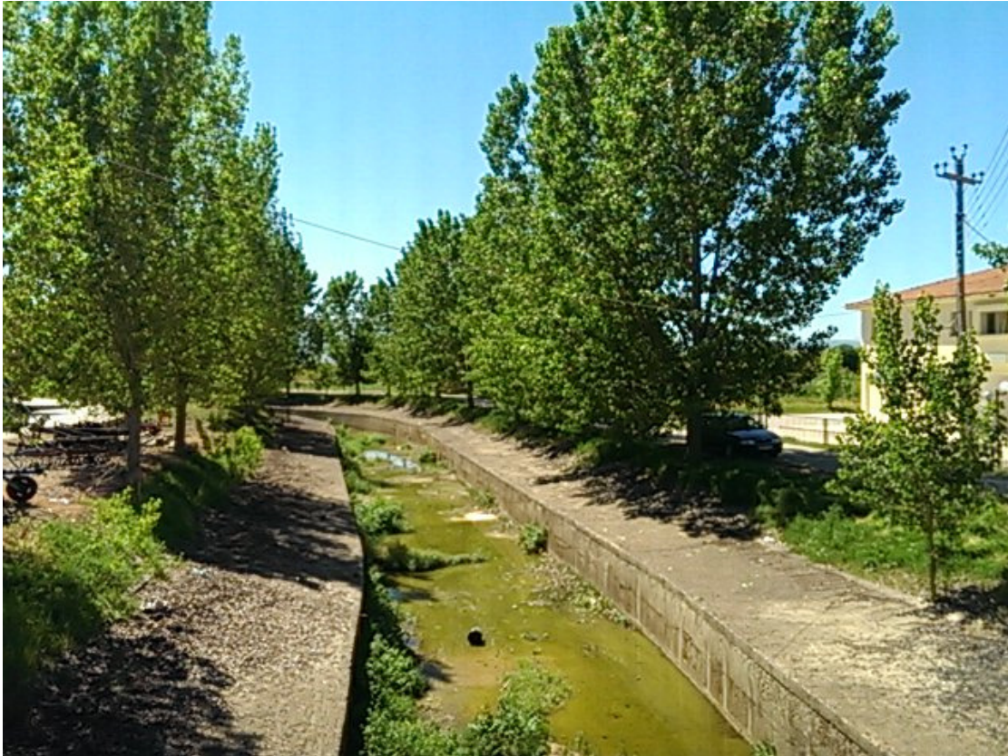
Φωτ. 7: Π. ΚΑΚΑΡΑΣ. ΑΝΑΝΤΗ ΤΗΣ ΓΕΦΥΡΑΣ ΕΠΕΝΔΕΔΥΜΕΝΗ ΔΙΑΤΟΜΗ.
