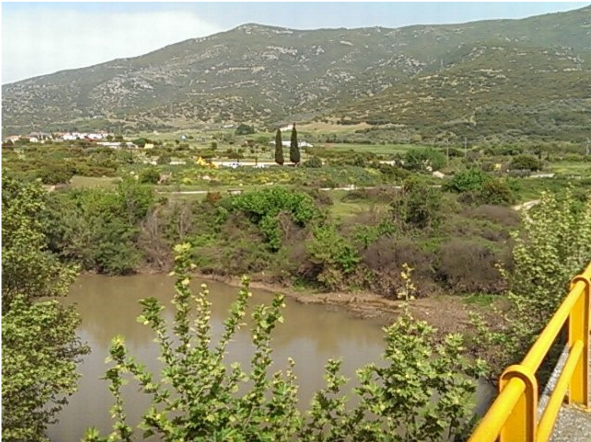
Φωτ. 9: Π.ΠΗΝΕΙΟΣ. Η ΚΟΙΛΑΔΑ ΤΩΝ ΤΕΜΠΩΝ ΑΝΑΝΤΗ ΤΗΣ ΓΕΦΥΡΑΣ ΕΠΙ ΤΗΣ ΟΔΟΥ ΓΟΝΝΩΝ – ΑΜΠΕΛΑΚΙΩΝ.ΣΤΗΝ ΠΕΡΙΟΧΗ ΣΗΜΕΙΩΝΟΝΤΑΙ ΣΗΜΑΝΤΙΚΕΣ ΠΛΗΜΜΥΡΕΣ.
