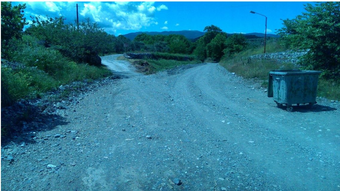
Φωτ. 3: Η ΚΟΙΤΗ ΤΟΥ ΧΕΙΜΑΡΡΟΥ ΣΕ ΘΕΣΗ ΛΙΓΟ ΑΝΑΝΤΗ ΤΗΣ ΕΚΒΟΛΗΣ. ΑΡΙΣΤΕΡΑ, ΚΑΤΑ ΤΗΝ ΡΟΗ, ΔΙΑΚΡΙΝΟΝΤΑΙ ΣΥΡΜΑΤΟΚΙΒΩΤΙΑ ΠΡΟΣΤΑΣΙΑΣ.
