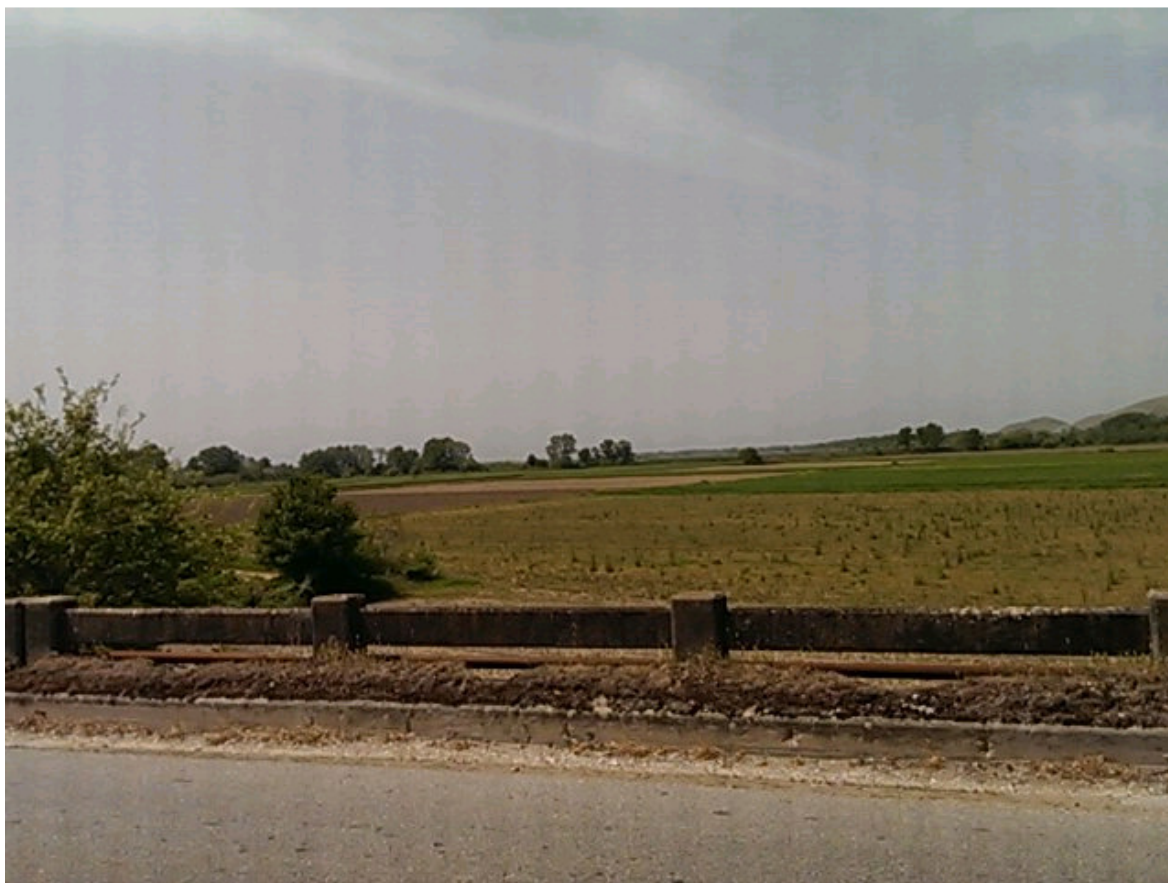
Φωτ. 4: Π. ΠΗΝΕΙΟΣ, ΚΑΤΑΝΤΗ ΣΥΜΒΟΛΗΣ ΝΕΟΧΩΡΙΤΗ. ΓΕΦΥΡΑ ΣΤΗΝ ΟΔΟ ΦΑΡΚΑΔΟΝΑ – ΚΕΡΑΜΙΔΙ. ΣΤΗΝ ΠΕΡΙΟΧΗ ΕΧΟΥΝ ΣΗΜΕΙΩΘΕΙ ΣΗΜΑΝΤΙΚΕΣ ΠΛΗΜΜΥΡΕΣ.
