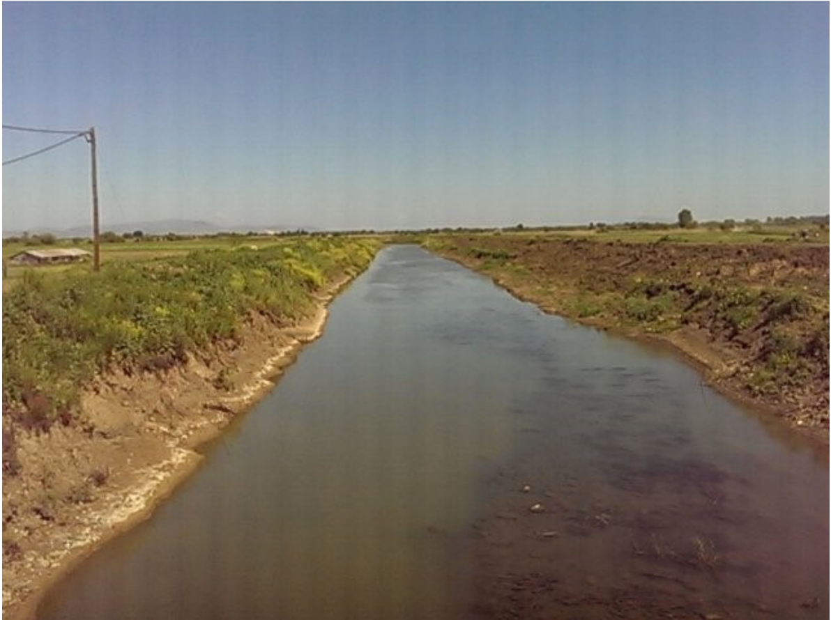
Φωτ. 10: Ο Π. ΜΕΓΑΣ ΑΠΟ ΓΕΦΥΡΑ ΣΤΗΝ ΟΔΟ ΑΓ.ΤΡΙΑΔΑ ΚΑΡΔΙΤΣΟΜΑΓΟΥΛΑ. ΔΙΑΚΡΙΝΟΝΤΑΙ ΟΙ ΕΡΓΑΣΙΕΣ ΚΑΘΑΡΙΣΜΟΥ ΤΗΣ ΚΟΙΤΗΣ.
