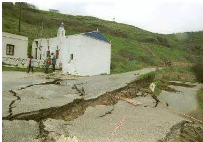
Σχήμα 5.16: Καθιζήσεις στο οδικό δίκτυο
