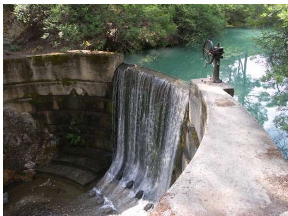
Σχήμα 7.12: Λιμνοδεξαμενή Επτά Πηγών
