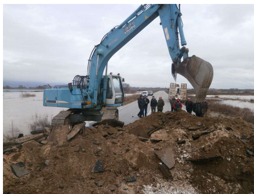
Σχήμα 7.40: Ε.Ο. Νέας Κεσσάνης-Αβδήρων. συνεργεία της Πολιτικής Προστασίας έσπασαν στη μέση το δρόμο σε μια προσπάθεια να απομακρύνουν τα συσσωρευμένα νερά.
