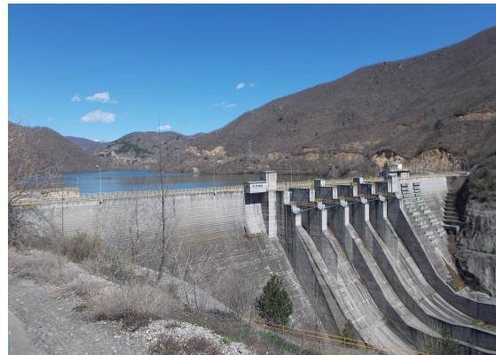
Σχήμα 7.34: ΥΗΕ Πλατανόβρυσης Πηγή: αυτοψία Αναδόχου
