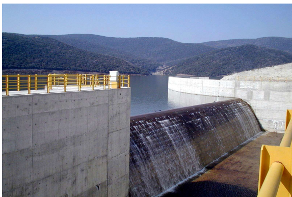
Σχήμα 7.30: Φράγμα Γρατινής. Πηγή: http://www.aegek.gr/new/gre/projects08.html
