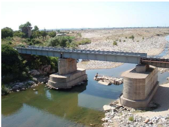
Σχήμα 7.14: Ποταμός Κομφάτος (ή Ξηροπόταμος), σιδηροδρομική γέφυρα στην περιοχή Ίασμος.
