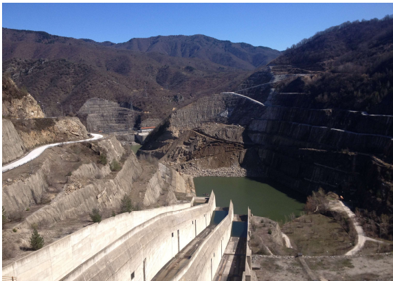
Σχήμα 7.33: ΥΗΕ Θησαυρού Πηγή: αυτοψία Αναδόχου
