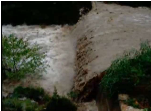
Σχήμα 7.7: Υπερχείλιση στο Φράγμα «Δοκίμ» στα Βρασνά
