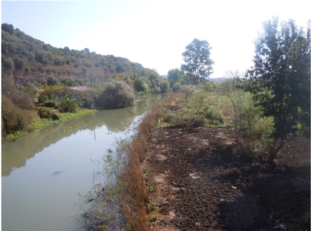
Φωτ. 8: Π. ΛΟΥΡΟΣ, ΑΝΑΝΤΗ ΓΕΦΥΡΑΣ ΠΕΤΡΑΣ
