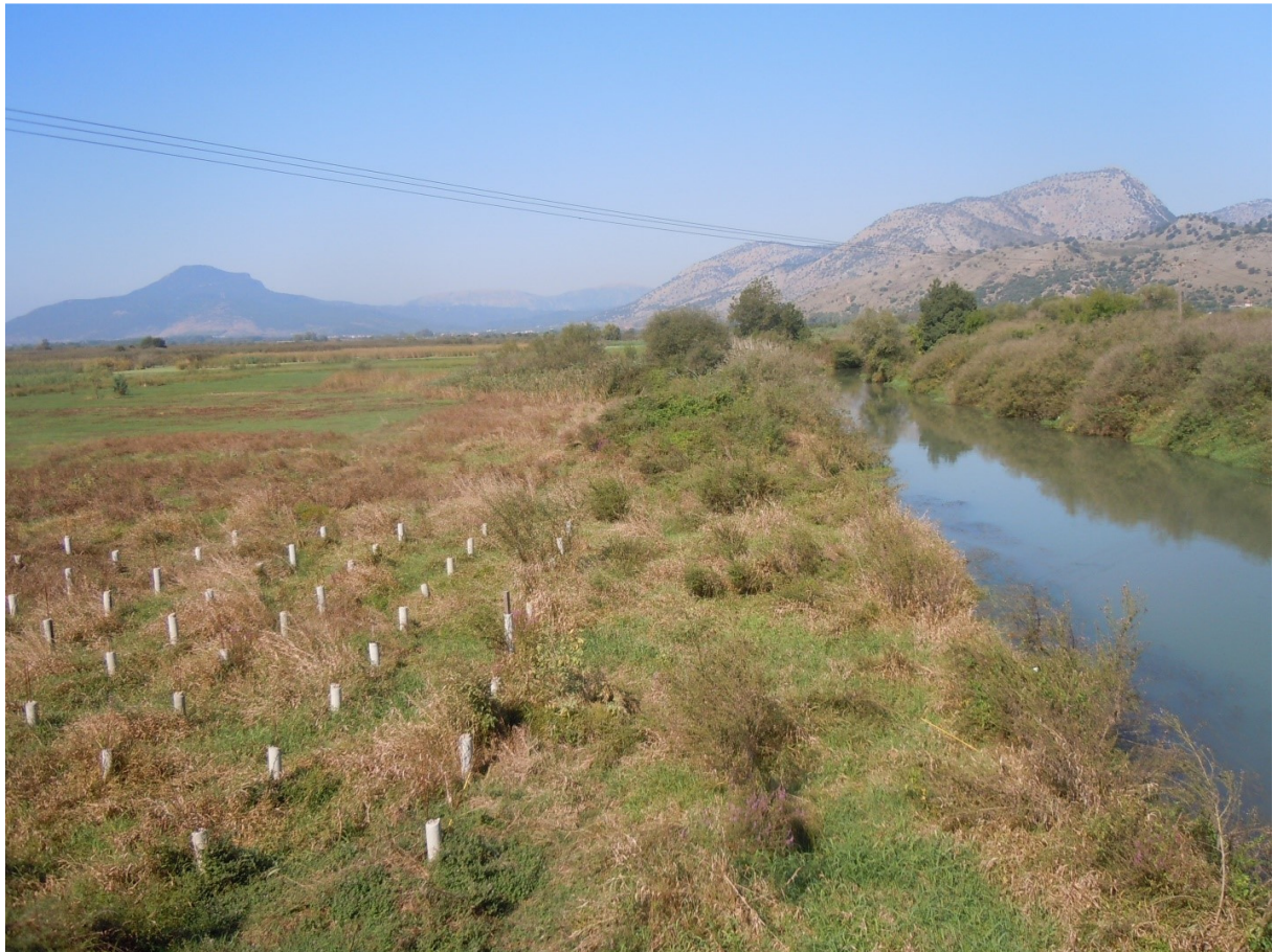
Φωτ. 7: Π. ΛΟΥΡΟΣ ΣΤΗΝ ΠΕΡΙΟΧΗ ΤΗΣ ΠΕΤΡΑΣ, ΚΑΤΑΝΤΗ ΓΕΦΥΡΑΣ
