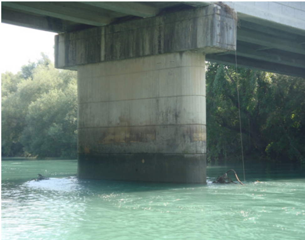
Εικόνα 5-48: Όψεις γέφυρας Γουριάς - Πεντάλοφου από ανάντη (άνω) και από τα κατόντη (κάτω) (πηγή: «Έρευνα Κατάκλυσης Κοίτης Ποταμού Αχελώου Κατόντη του Φράγματος του Στράτου», ΕΜΠ, 2010)
