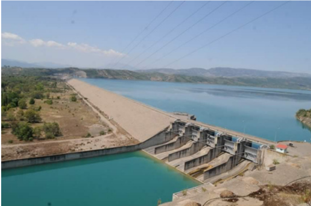
Εικόνα 5-3: Το φράγμα του Στράτου (πηγή: Διαδίκτυο)
