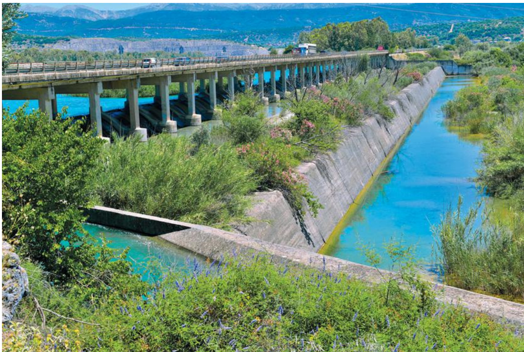
Εικόνα 5-4: Η γέφυρα του π. Αχελώου στο φράγμα του Στράτου, κατάντη της οποίας εκτείνεται η περιοχή μελέτης (πηγή: Διαδίκτυο)
