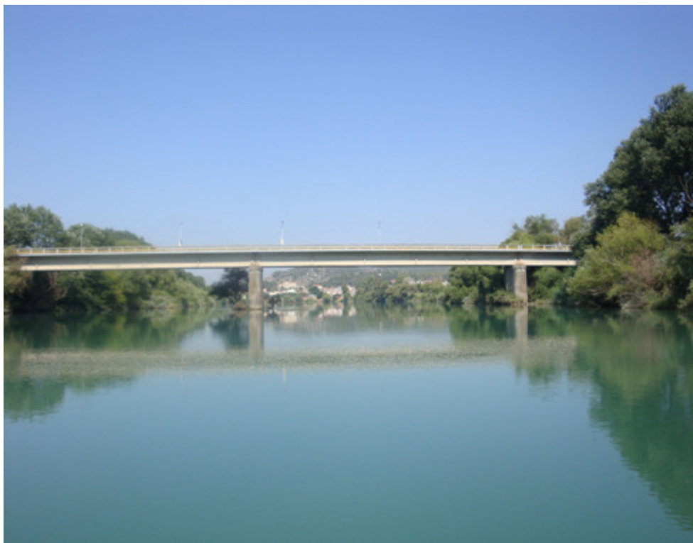
Εικόνα 5-50: Όψεις γέφυρας Μάστρο - Κατοχή από κατάντη (πηγή: «Έρευνα Κατάκλυσης Κοίτης Ποταμού Αχελώου Κατάντη του Φράγματος του Στράτου», ΕΜΠ, 2010)
