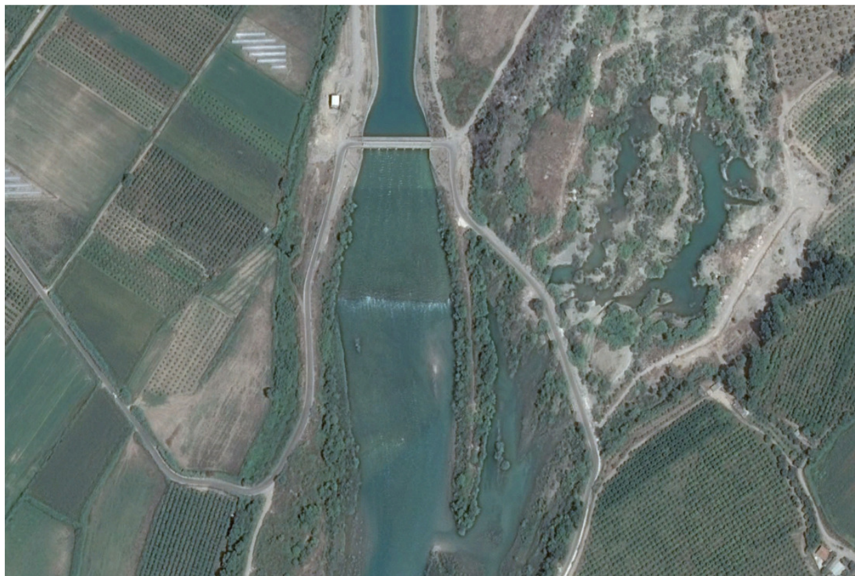
Εικόνα 5-14: Το έργο εξόδου της διώρυγας φυγής και η συμβολή με την παλαιά κοίτη του ποταμού (την κοίτη αμέσως κατάντη των υπερχειλιστών του φράγματος και έως την συμβολή με την διώρυγα) (πηγή: Google Earth)
