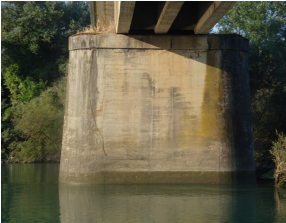
Εικόνα 5-52: Όψεις γέφυρας Νεοχώρι – Κατοχή προς τα κατάντη (πηγή: «Έρευνα Κατάκλυσης Κοίτης Ποταμού Αχελώου Κατάντη του Φράγματος του Στράτου», ΕΜΠ, 2010)
