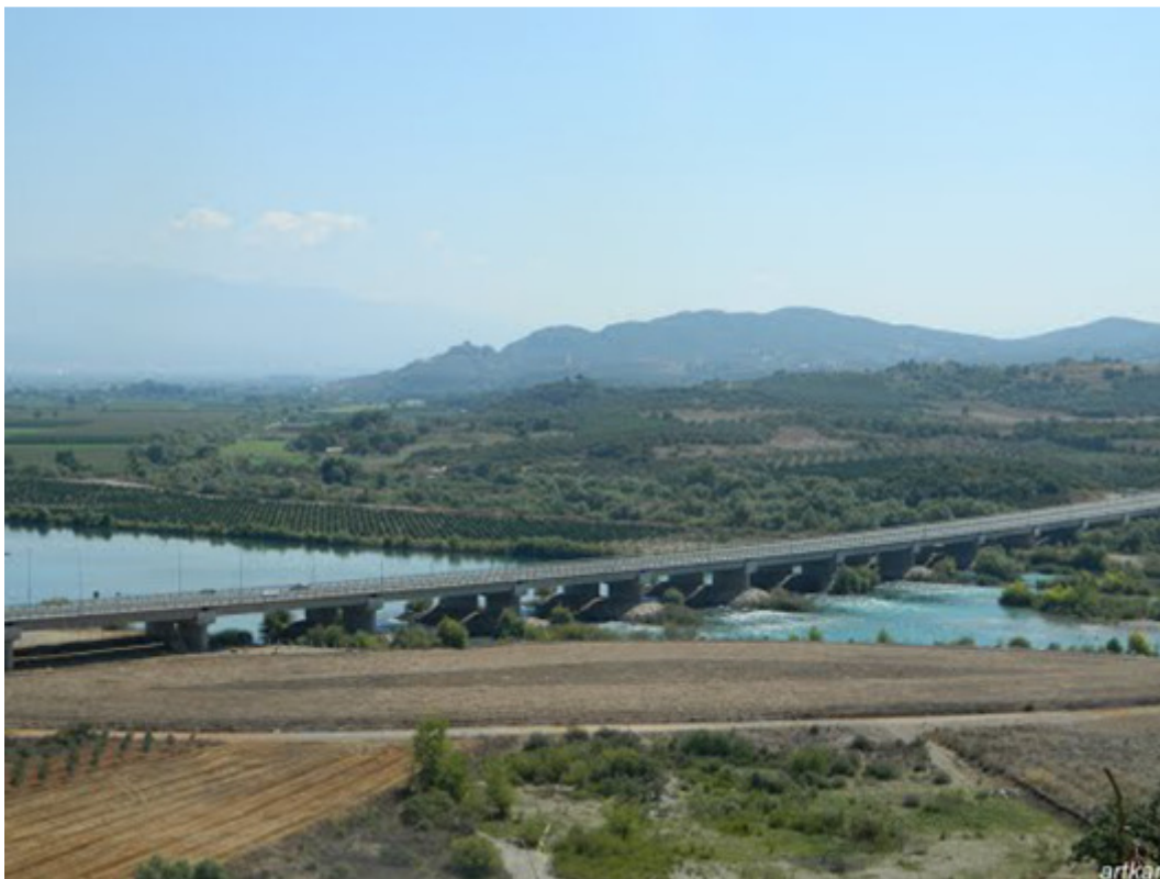
Εικόνα 5-46: Όψη γέφυρας Ιονίας οδού από ανάντη (πηγή: Google Earth)
