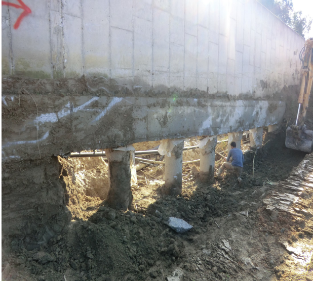
Εικόνα 4-10: Υποσκαφή πασσαλότοιχου ΒΙΟΚΑ
