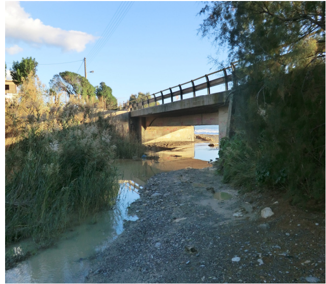
Εικόνα 4-7: Τεχνικό ρεμάτων Κεντριανού Κοτοβιανού πριν την εκβολή
