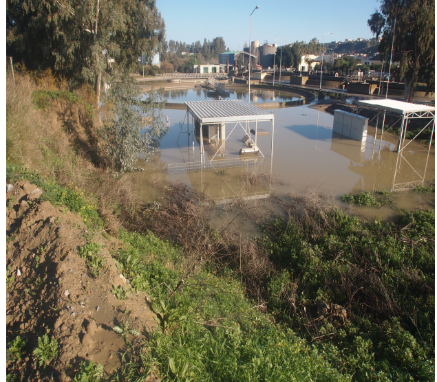
Εικόνα 4-11: Κατάκλυση εγκαταστάσεων ΒΙΟΚΑ
