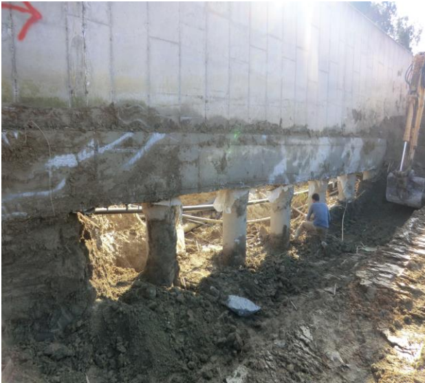
Φωτογραφία 7.5 : Υποσκαφή πασσαλότοιχου ΒΙΟΚΑ
