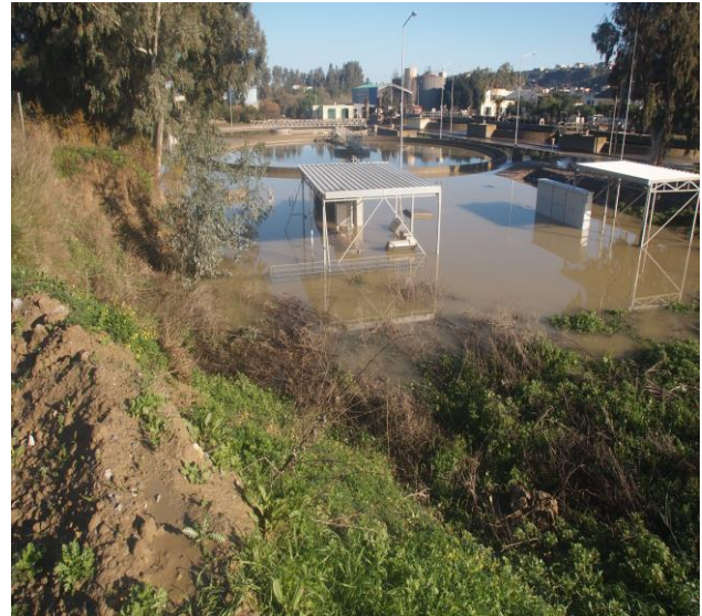
Φωτογραφία 7.6 : Κατάκλυση εγκαταστάσεων ΒΙΟΚΑ
