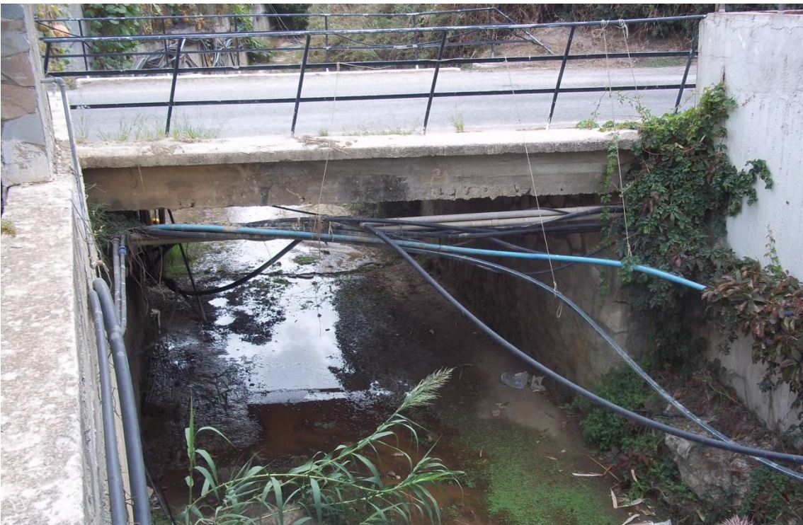
Φ 99: Χαρακτηριστικές φωτογραφίες πλακοσκεπή οχετού στην περιοχή Αγία Μαρίνα της Π.Ε. Χανίων (Κωδικός έργου: ΑΓ. ΜΑΡΙΝΑ 3).
