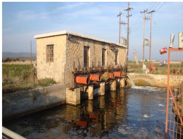
Φωτογραφία 4-4: Αντλιοστάσιο Τρινάσου.
