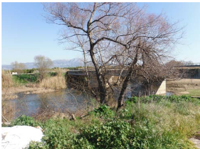
Φωτογραφία 4-1: Γέφυρα Ευρώτα μεταξύ Έλους και Λεήμονα
