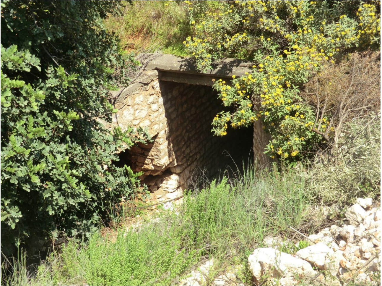
Φωτογραφία 4.3: Τεχνικό ρέματος βόρεια του οικισμού Ξηροπήγαδου επί της επαρχιακής οδού Κιβερίου - Άστρους.
