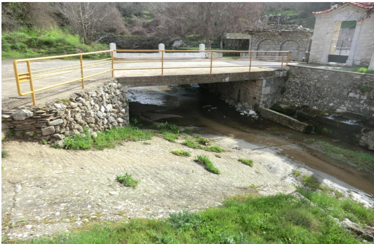
Φωτογραφία 4.1: Τεχνικό ρέματος εντός οικισμού Βερβένων.
