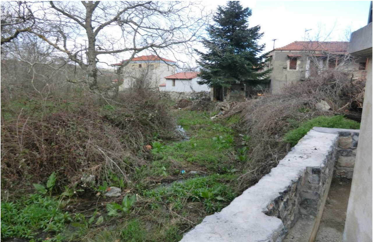
Φωτογραφία 4.2: Τεχνικό ρέματος εντός οικισμού Βερβένων.
