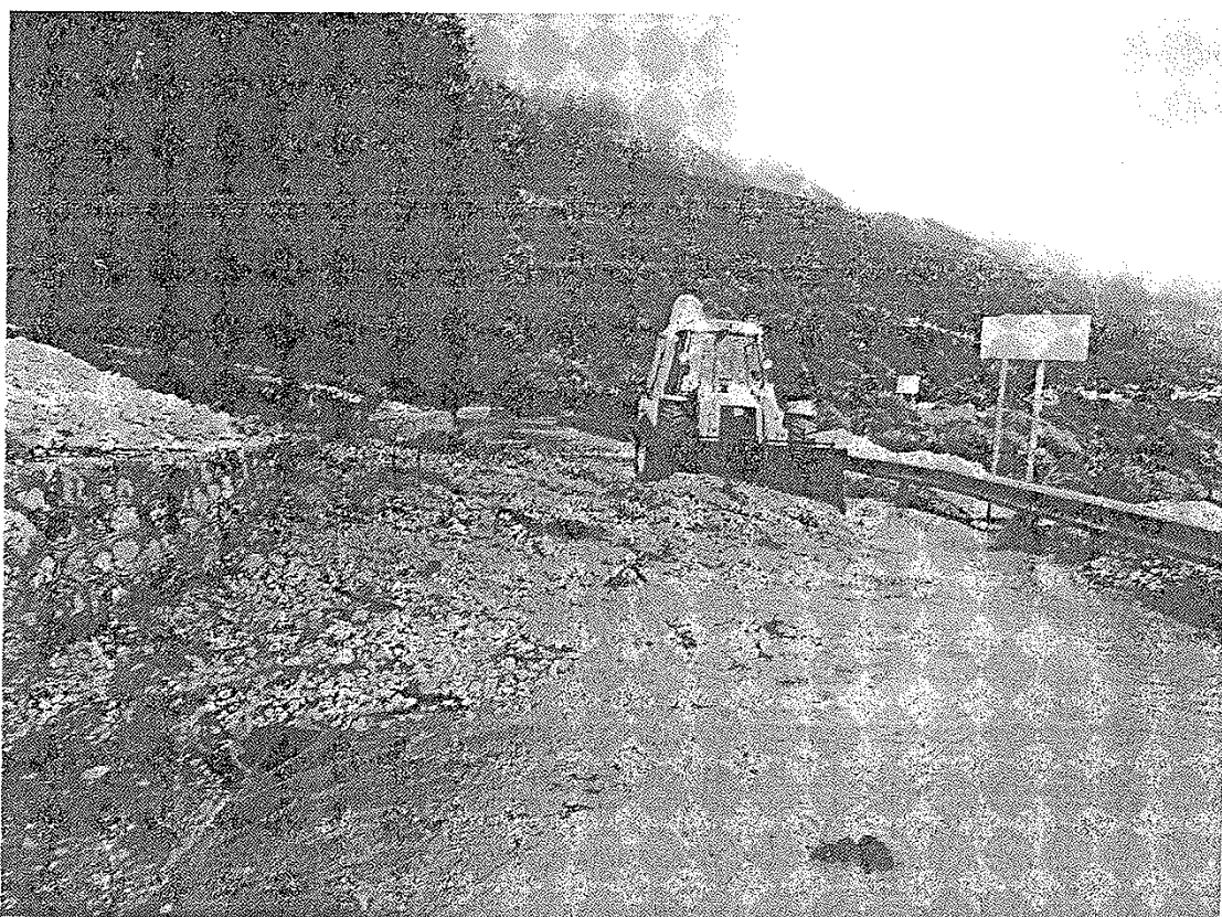
Φωτ. 18. Στερεοπαροχή στην επαρχιακή οδό υπ' αριθμ. 1 μέσω τοπικών υδατορεμάτων στην περιοχή Καρούζα-Βλαχάτα-Σμιοτάτα (υποέργο 14).
