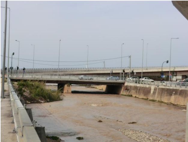
Εικόνα 4-10: Ανισόπεδος Κόμβος σύνδεσης Παραγλαύκειων αρτηριών με λιμάνι Πάτρας.
