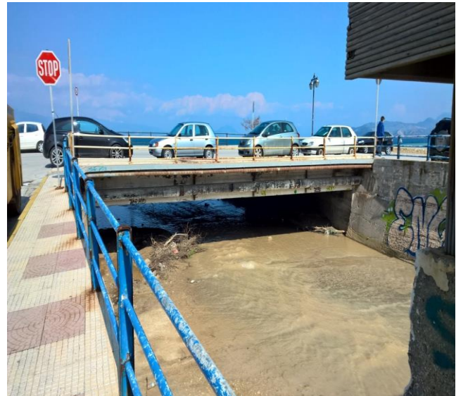
Εικόνα 4-7: Διευθετημένη κοίτη και τεχνικό Ρ. Ελισσώνα σε παραλιακή οδό εντός Κιάτου
