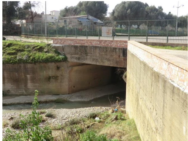
Εικόνα 4-13: Τεχνικό εισόδου κάλυψης Ρ. Σοχιά στην Αμαλιάδα
