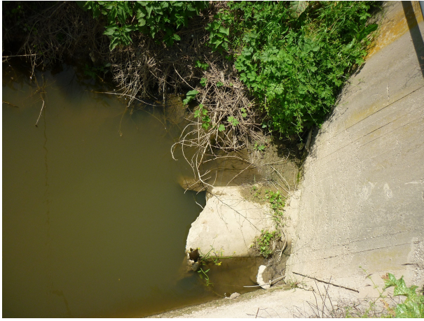
φωτογραφία 8 ημερομηνία λήψης 7 Απριλίου 2016. Το σημείο (Ζ) κατάντη. Διακρίνεται η χαμηλή ταχύτητα ροής και η διάμετρος του τσιμεντοσωλήνα.
