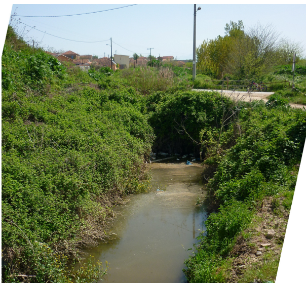
φωτογραφία 7 ημερομηνία λήψης 7 Απριλίου 2016. Το σημείο (Z) ανάντη. Διακρίνεται η χαμηλή ταχύτητα ροής και τα φερτά υλικά που συγκεντρώνονται.
