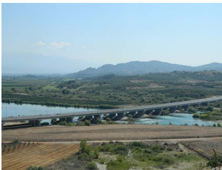
Σχήμα 4.3.3-4: Όψη γέφυρας Ιονίας οδού από ανάντη (πηγή: Google Earth)
