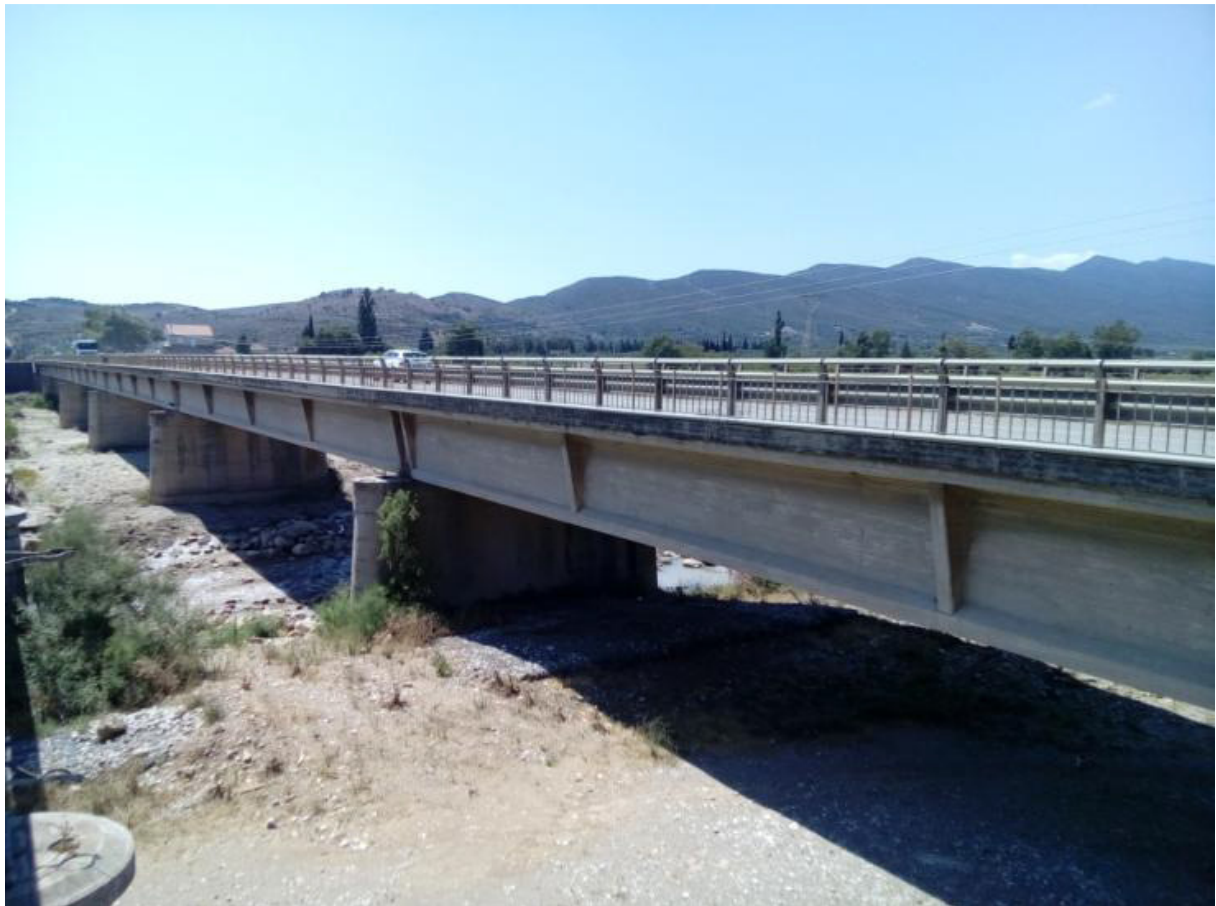
Φωτ. 1: Η ΓΕΦΥΡΑ ΕΠΙ ΤΟΥ Π. ΕΥΗΝΟΥ ΤΗΣ ΕΘΝΙΚΗΣ ΟΔΟΥ ΑΝΤΙΡΡΙΟΥ-ΑΓΡΙΝΙΟΥ
