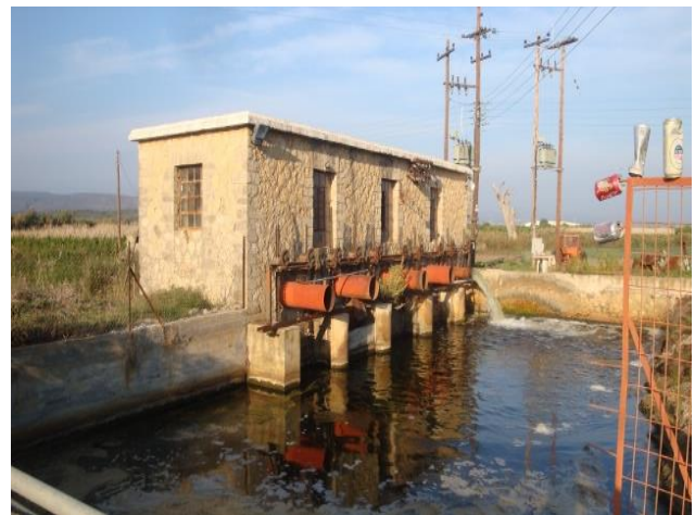
Φωτογραφία 7.4: Αντλιοστάσιο Τρινάσου.
