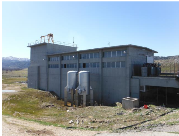
Φωτογραφία 7.12: Αντλιοστάσιο χαμηλής περιοχής γύρω από τη Λίμνη Τάκα
