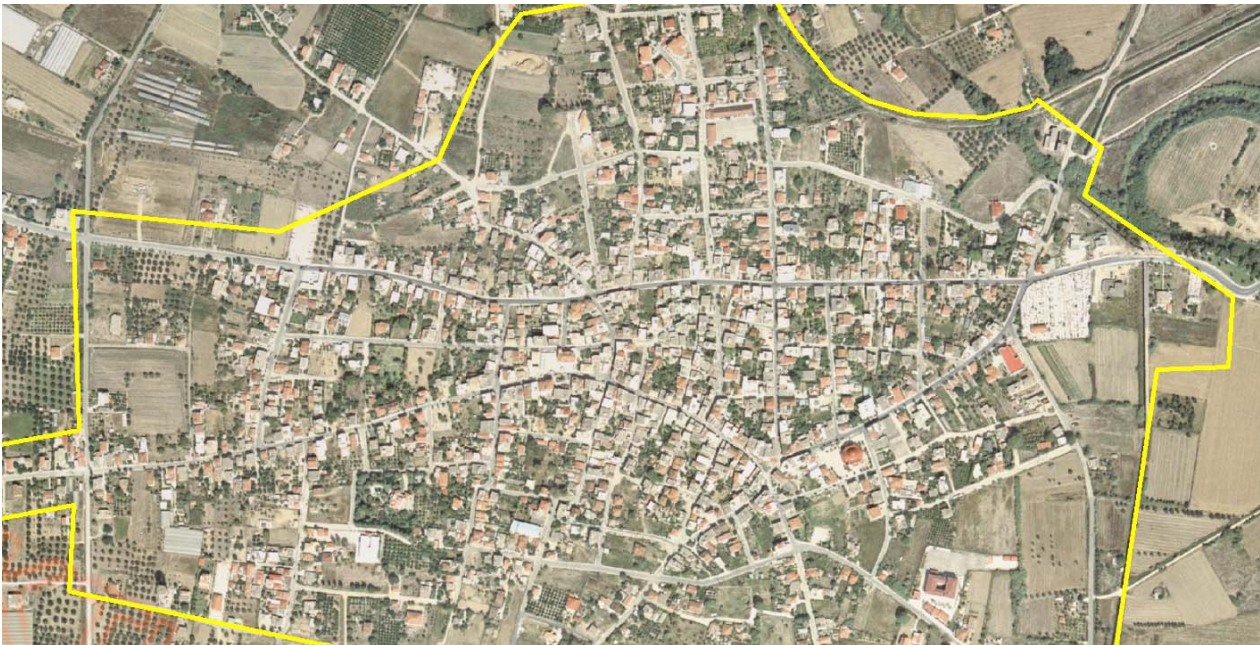
Εικόνα 3.1: Άποψη τμήματος του ορίου Σχεδίου Πόλης του Βαρθολομιού.
