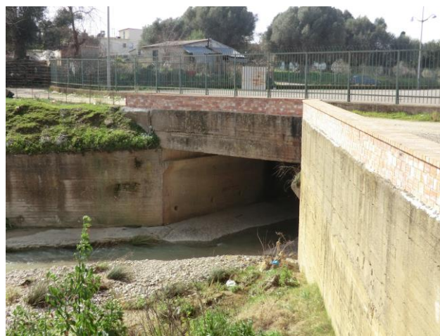
Φωτογραφία 7.12: Τεχνικό εισόδου κάλυψης Ρ. Σοχιά στην Αμαλιάδα
