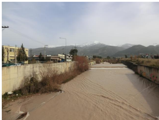
Φωτογραφία 7.10: Διευθετημένη κοίτη και αναβαθμός Γλαύκου.
