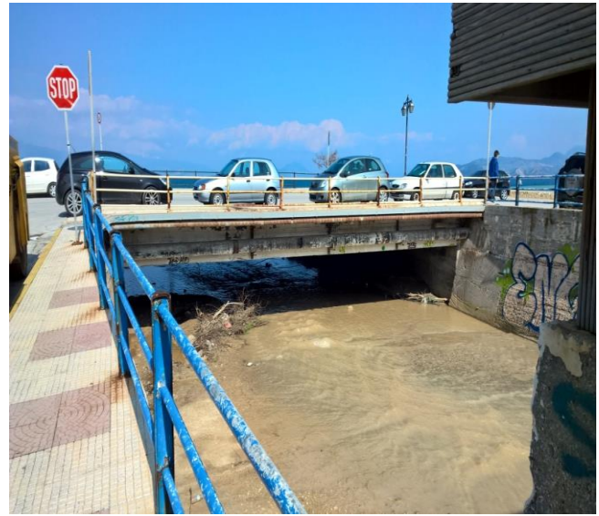
Φωτογραφία 7.6: Διευθετημένη κοίτη και τεχνικό Ρ. Ελισσώνα σε παραλιακή οδό εντός Κιάτου
