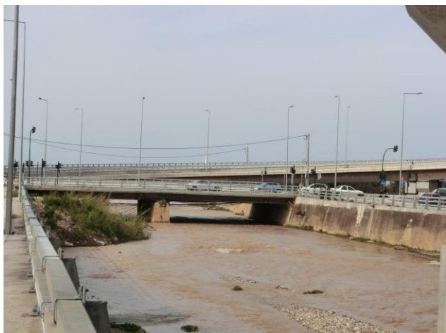
Φωτογραφία 7.9: Ανισόπεδος Κόμβος σύνδεσης Παραγλαύκειων αρτηριών με λιμάνι Πάτρας.
