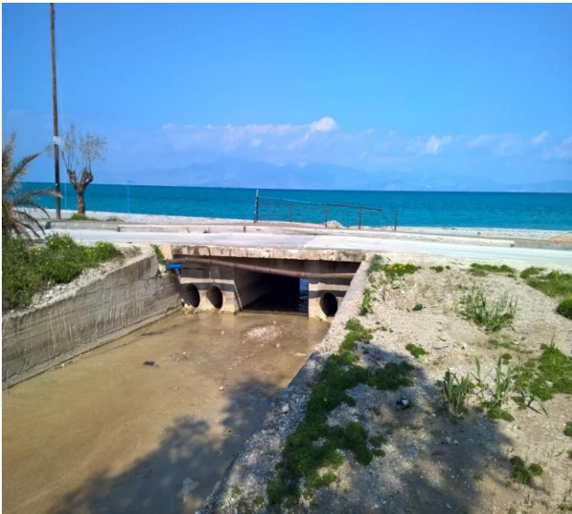
Φωτογραφία 7.5: Τεχνικό Ρ. Κυρίλλου στην εκβολή του στην παραλιακή οδό εντός Κιάτου
