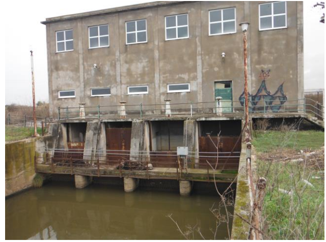
Φωτογραφία 4-10: Αντλιοστάσιο Σπιάτζας.
