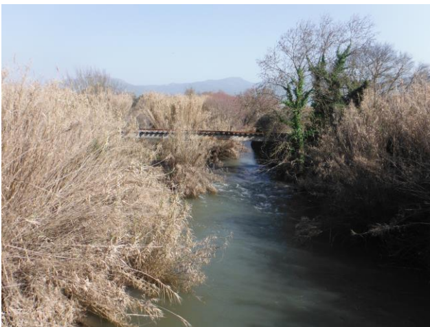
Φωτογραφία 4-5: Χ. Μαυροζούμενα, Σιδηροδρομική γέφυρα ανάντη Μελιγαλά.
