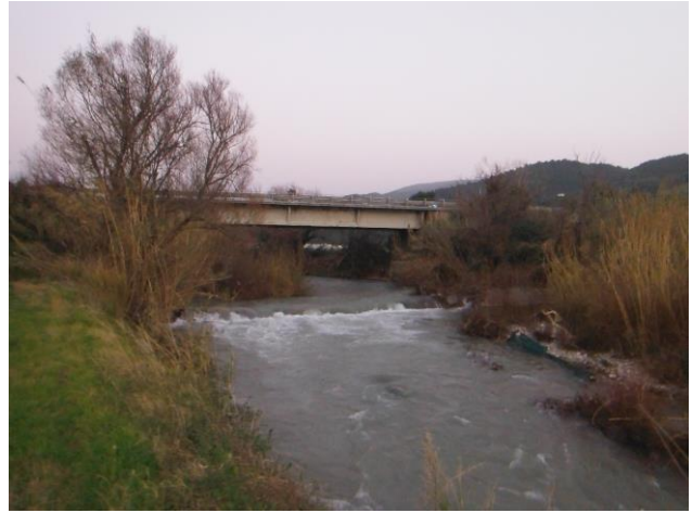
Φωτογραφία 4-12: Π. Νέδα. Τεχνικό Επαρχιακής Οδού Πύργου - Κυπαρισσίας
