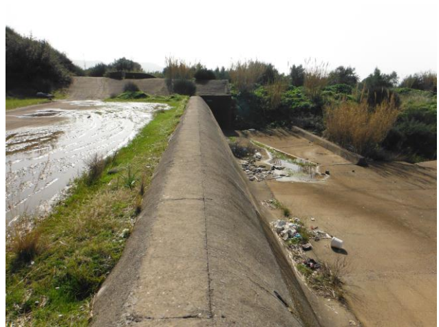
Φωτογραφία 4-6: Φράγμα Χ. Ξερίλα.
