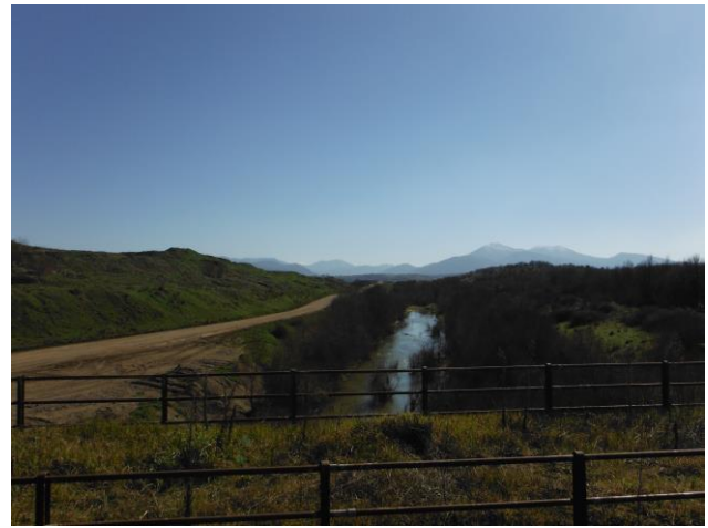
Φωτογραφία 7.8: Κοίτη Αλφειού από γέφυρα Επαρχιακής Οδού Σύρτζι - Μεγαλόπολη.
