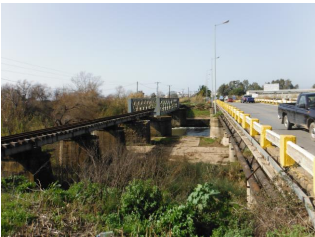
Φωτογραφία 7.3: Οδική και σιδηροδρομική γέφυρα Πάμισου επί διευθετημένης κοίτης.
