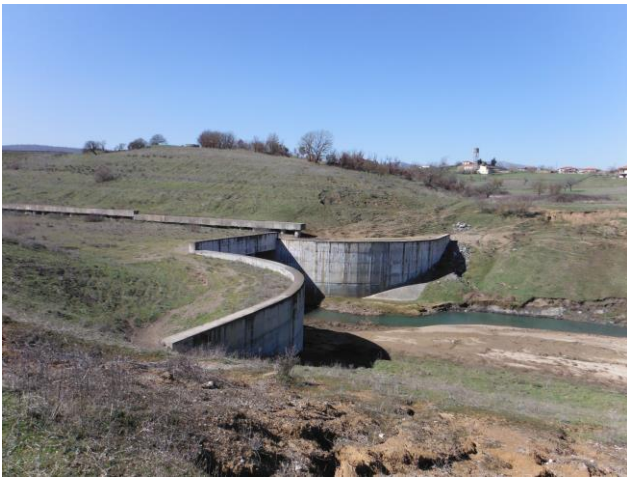
Φωτογραφία 7.7: Είσοδος τεχνικού κάλυψης Αλφειού στην περιοχή Τριποτάμου.
