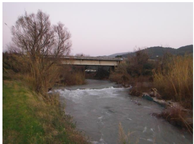
Φωτογραφία 7.12: Π. Νέδα. Τεχνικό Επαρχιακής Οδού Πύργου - Κυπαρισσίας
