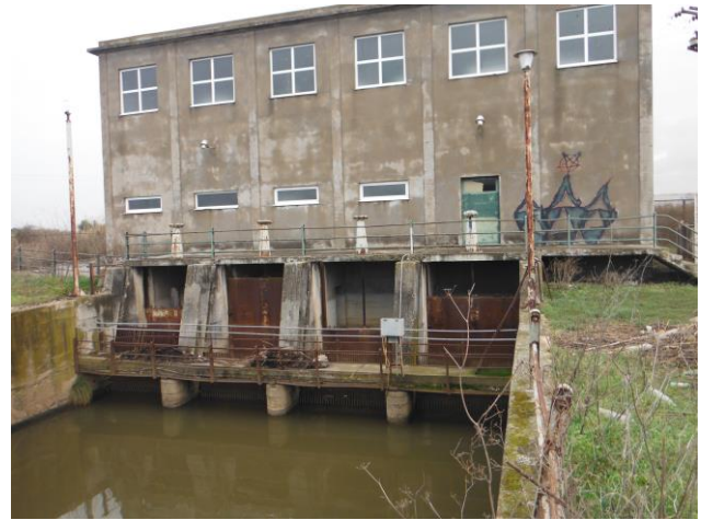
Φωτογραφία 7.10: Αντλιοστάσιο Σπιάτζας.
